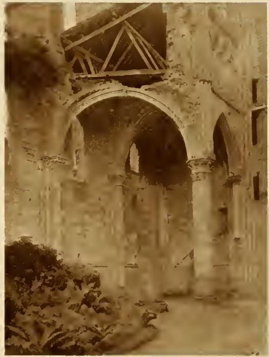
FIG. 30. Abbaye, Longpont, (Aisne). South side aisle.
