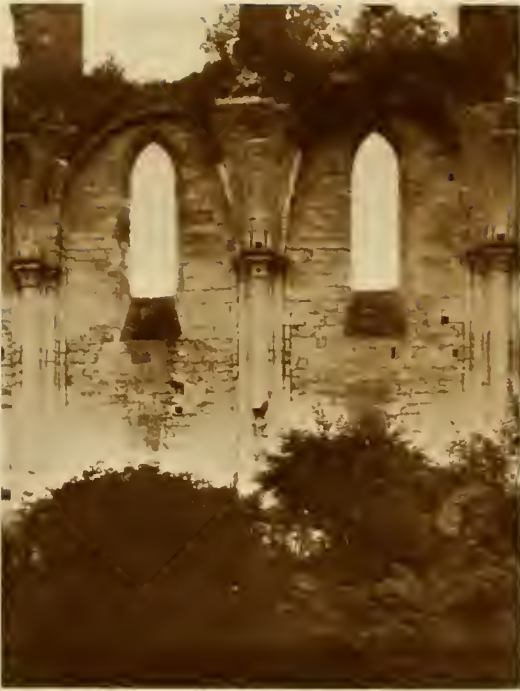
FIG. 31. Abbaye, Longpont, (Aisne). South side aisle.
