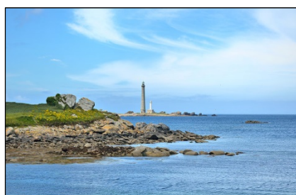
6e — Le phare de l'Île Vierge, construit entre 1842 et 1845 et situé sur la commune de Plouguerneau en Bretagne.
