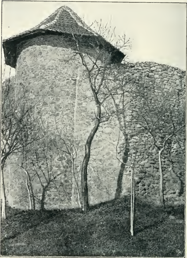
Stadtbefestigung von Osterode a. H.
