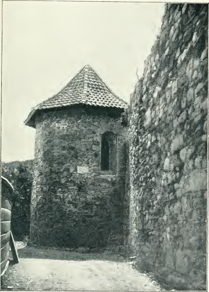
Stadtbefestigung von Osterode a. H.
