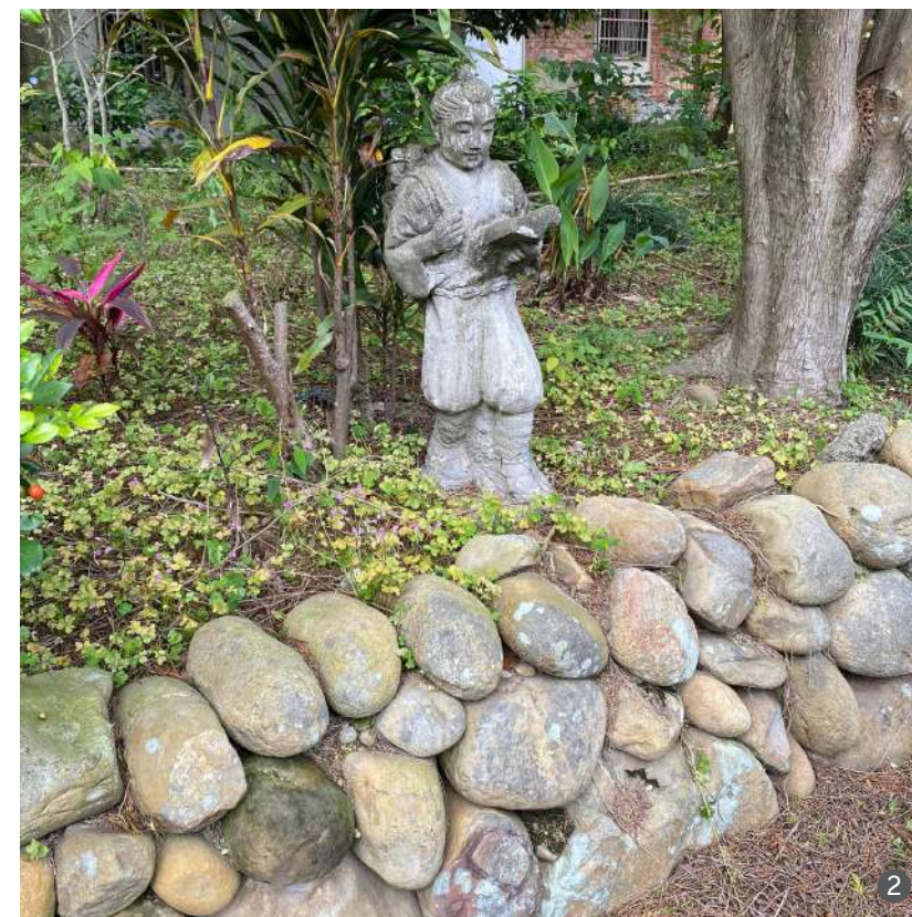
01 在客家傳統建築鄭氏祠堂中，可以看見由牛欄河和鳳山溪河底卵石做的牆角，有防水、承重之用。02 客家多居住在丘陵地，為了整地會有許多的砌石護坡，砌石扎實沒有混凝土，全由石頭堆疊而成。此景可於鄭氏祠堂見到。
