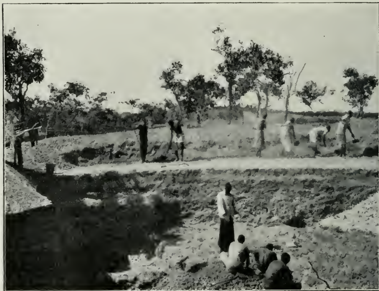
Abb. 21. Arbeiten im Schürfgraben unter Leitung des Oberaufsehers.
