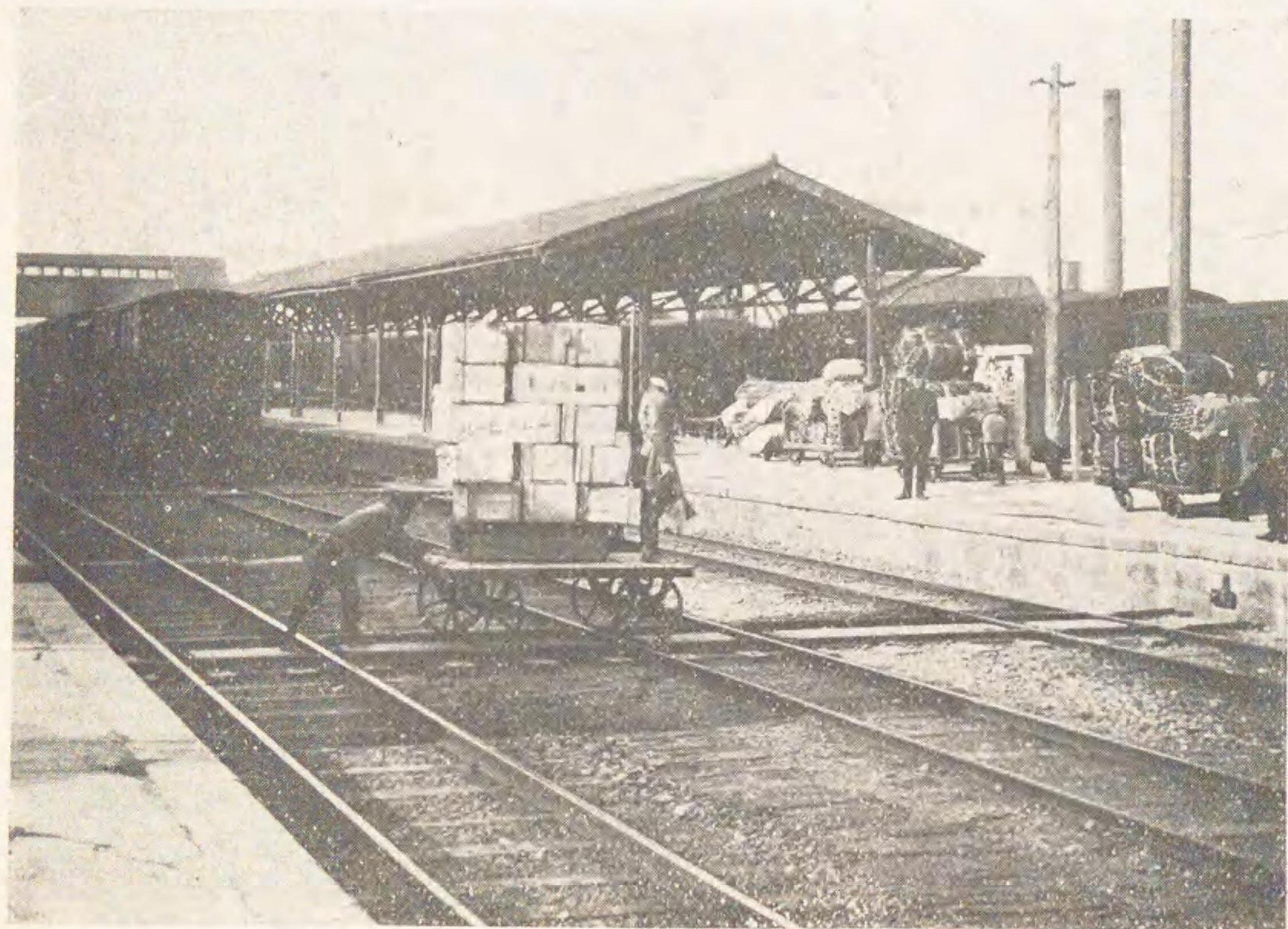
線路横斷荷物運搬車作業
