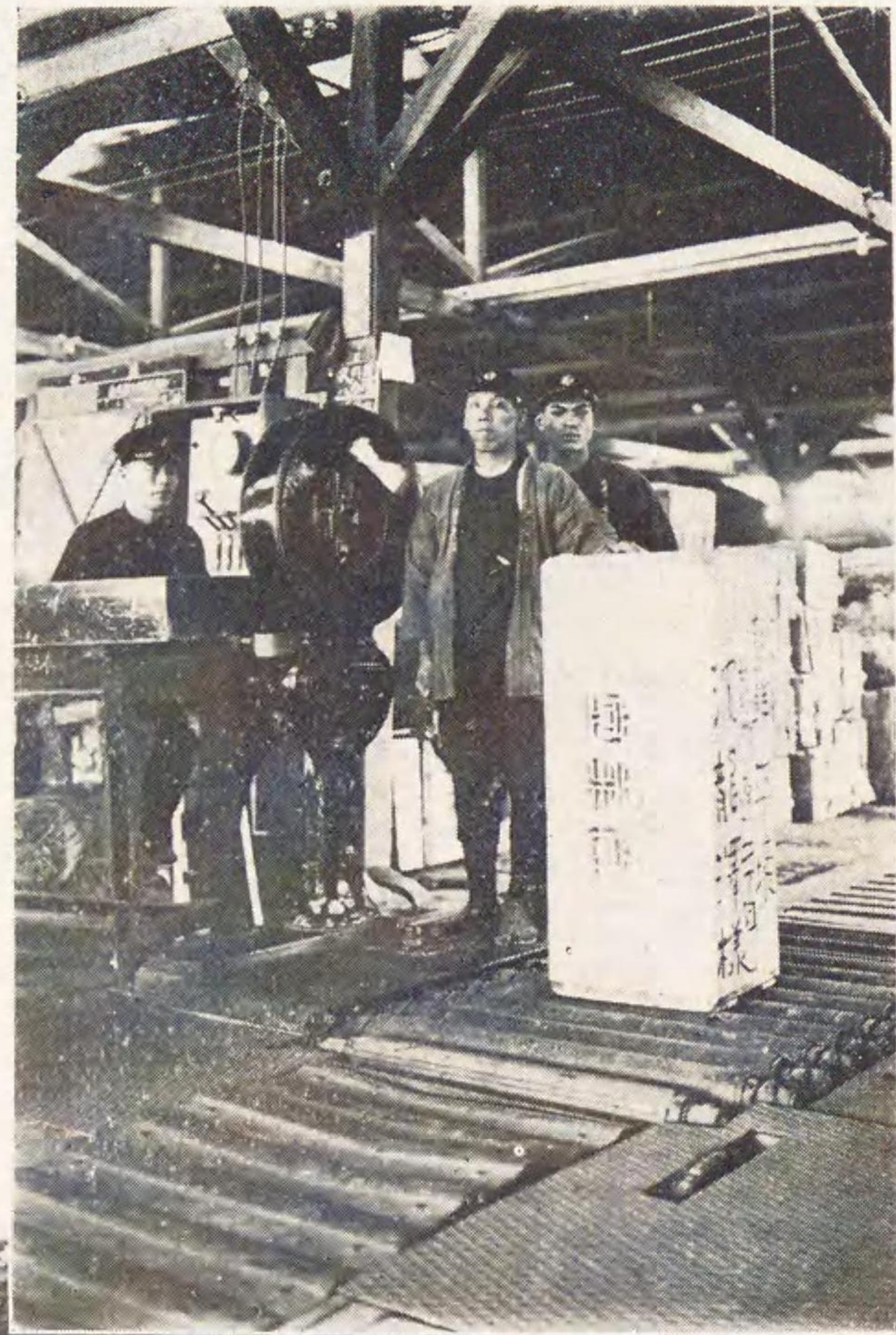
コンベヤー 小口扱貨車積込
