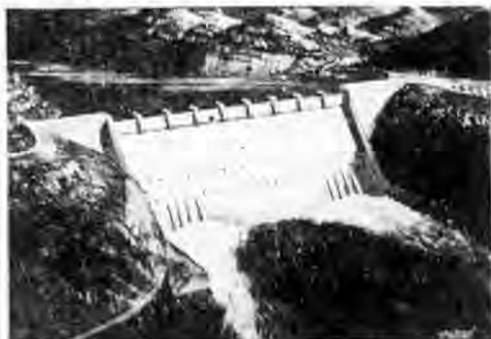
(圖三) 揚子江大壩寫真圖, 是世界上最大的混凝土壩, 是中國工業建國的關鍵。
