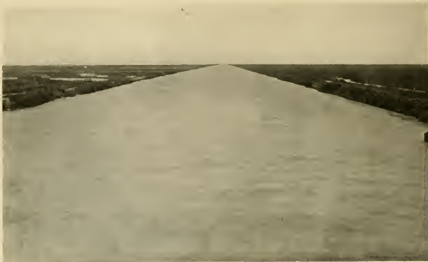
Hauptkanal unserer Bewässerungsanlage. Der Kanal ist 100 Fuß breit und sechs Fuß tief.
