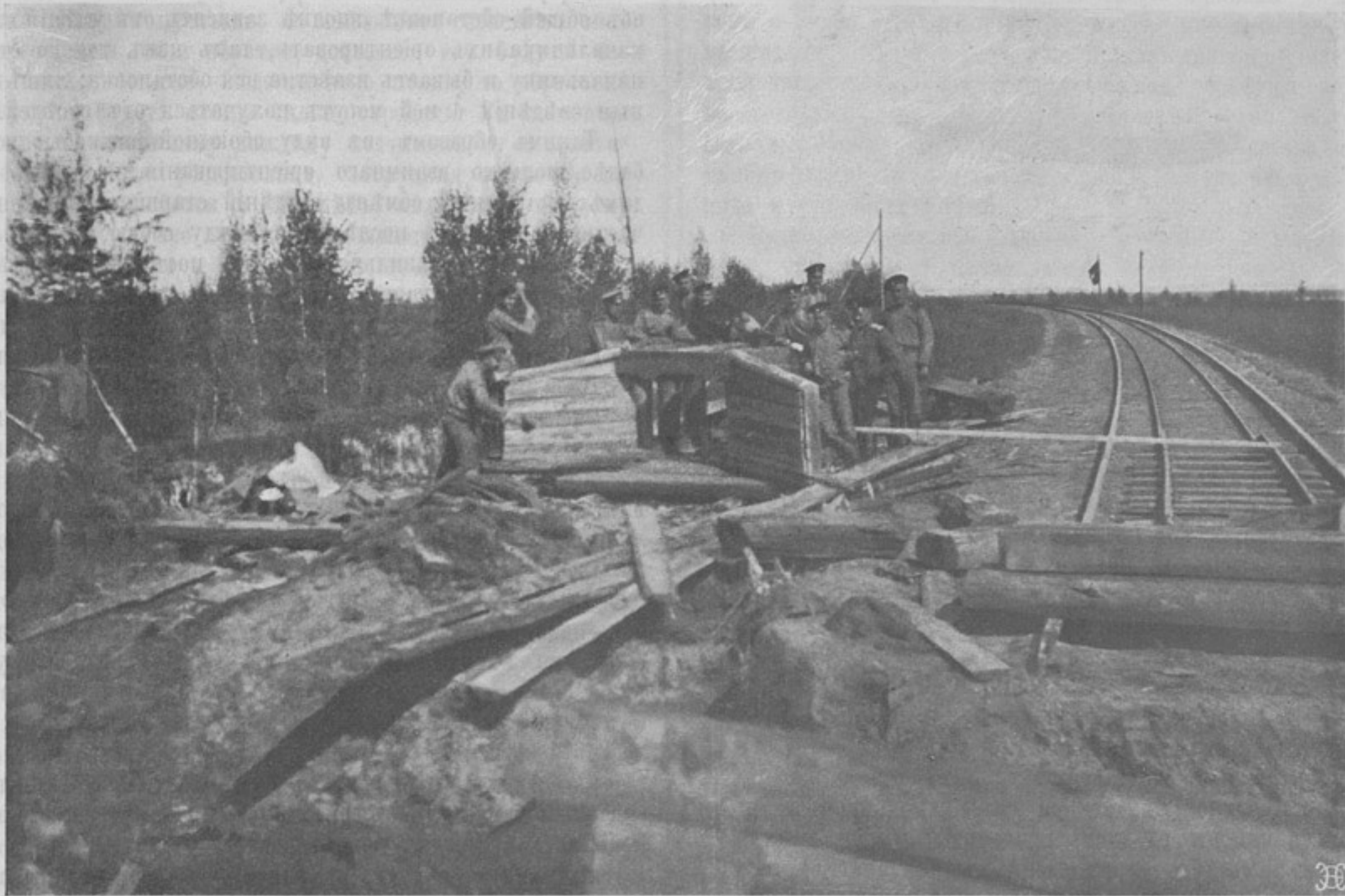
Вводна водоспускной трубы на размытѣ. (Къ корресп. „Хабаровскъ“).
