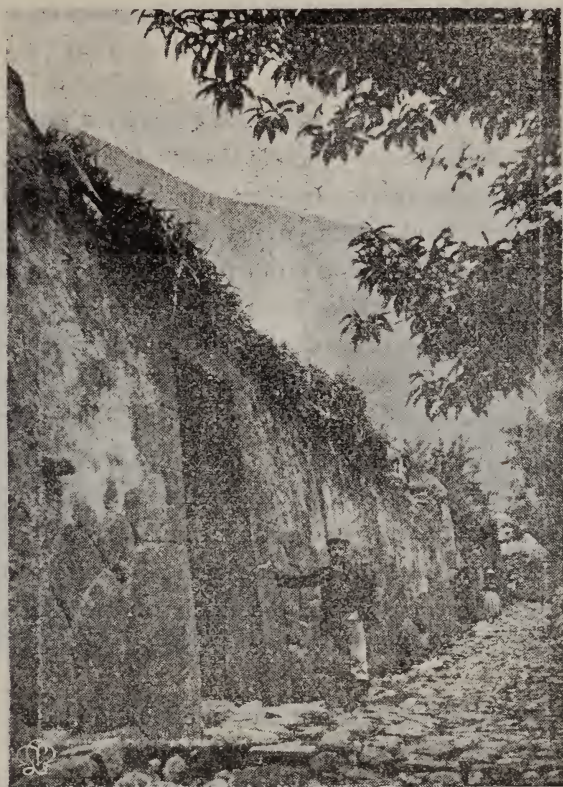
OLLANTAITAMBO.—PUERTA EN UNA CALLE INCAICA.
