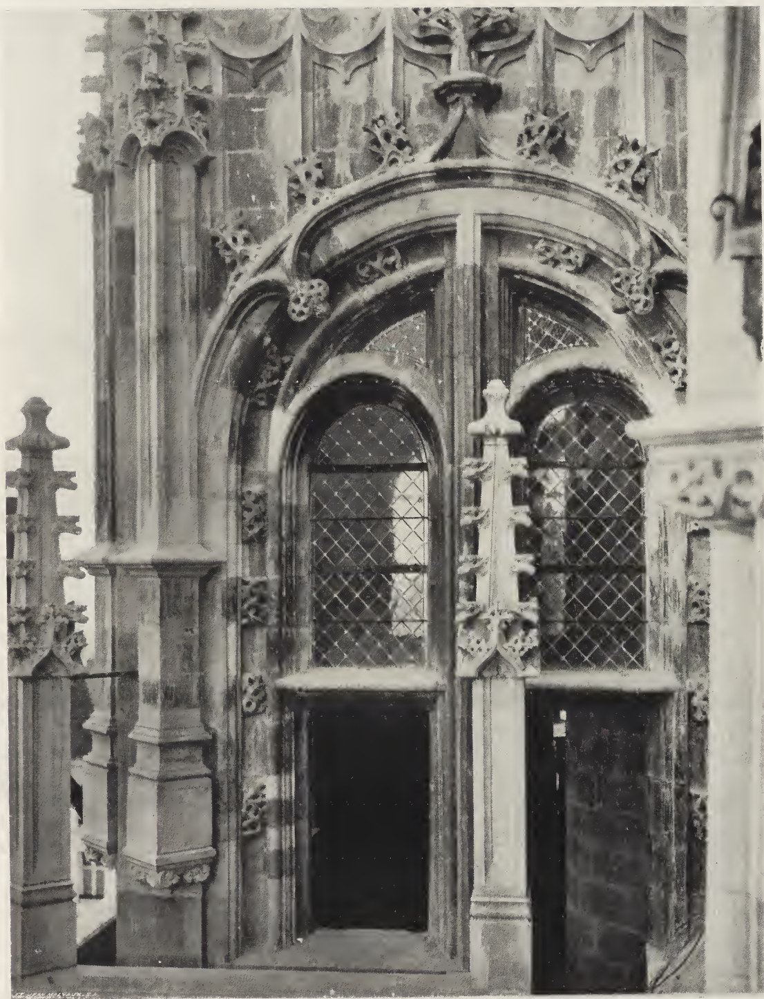
HOTEL DE VILLE D'AUDENARDE ÉTAGE DE L'HORLOGE. VUE LATÉRALE. APRÈS LA RESTAURATION DE M. LANGEROCK.
