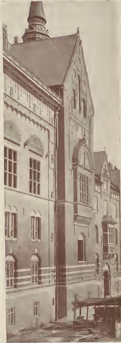
Mittelpartie einer Seitenfäçade.
