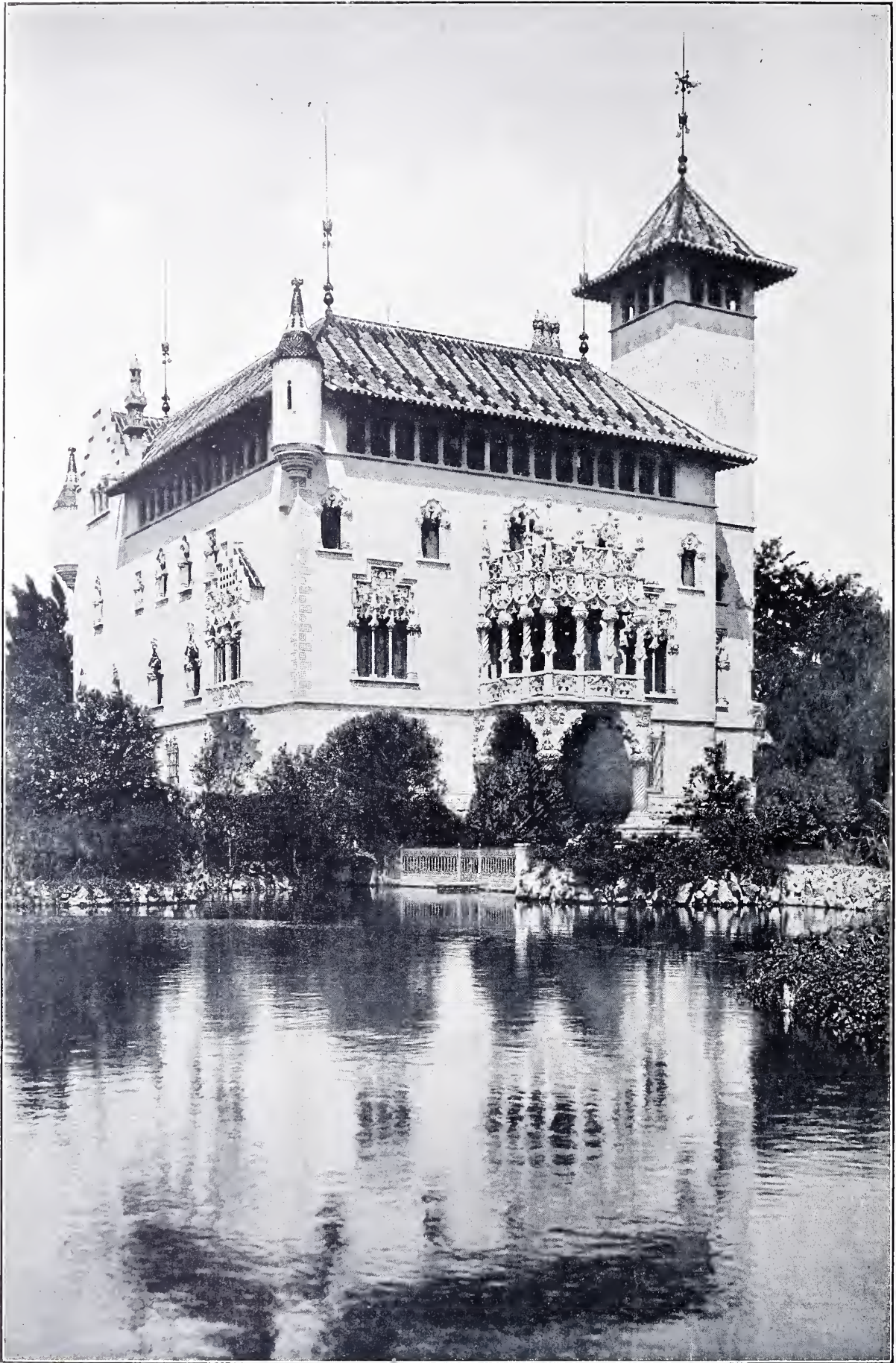
Casa de D. José Garí, en el Cros, Argentina, construída en 9 meses, en 1899
