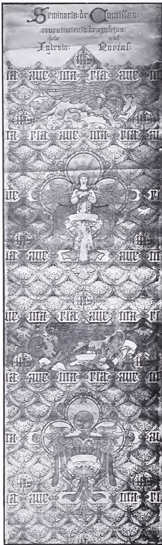
Revestimiento de azulejos de la fachada de la iglesia del Seminario de Comillas
