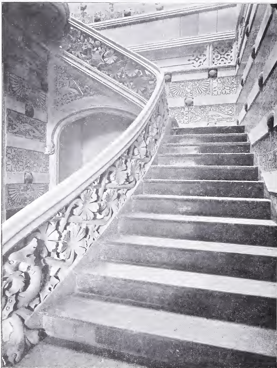
Escalera de la casa Thomas
