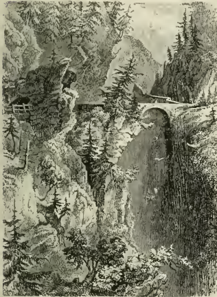
Ur. 5. Via mala im Hinter-Rheinthal: Zweite Brücke.
