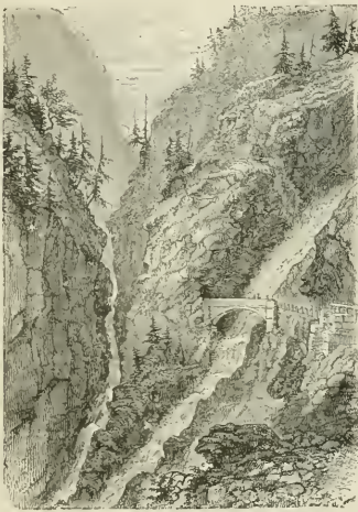
Nr. 3. Simplonstrasse: Gallerie von Condo.
