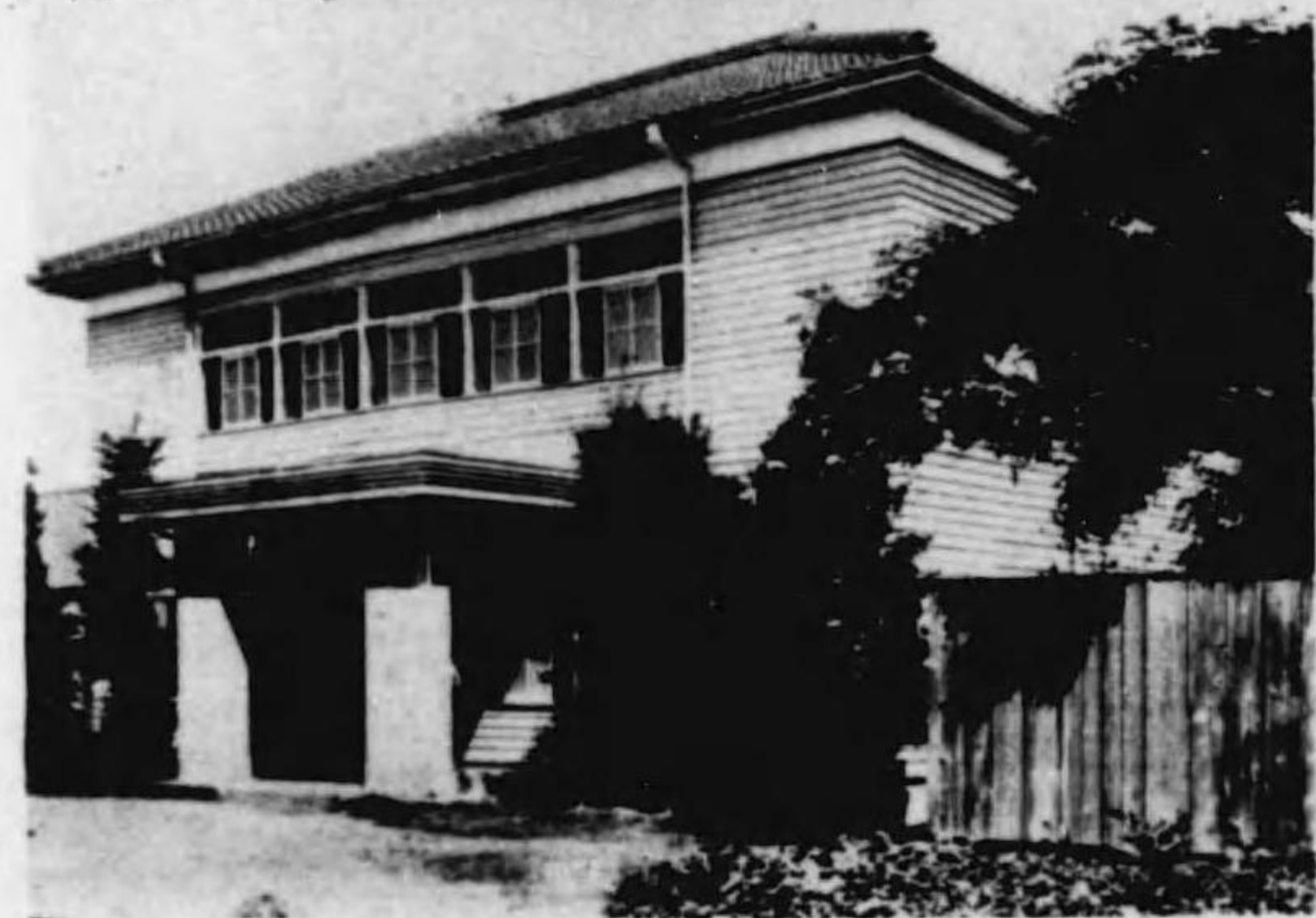
志太支所 志太郡青島町前島
