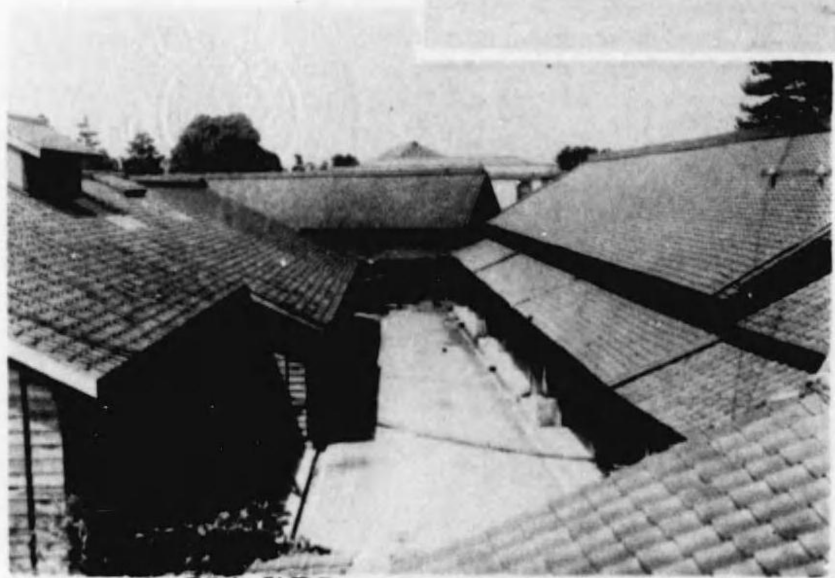
袋井支所倉庫
