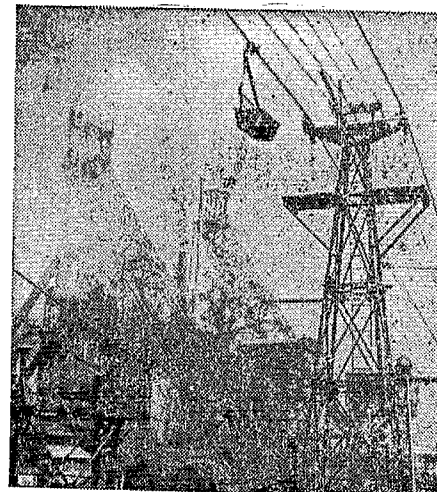
在我們大規模經濟建設中佔有重要地位的煉鋼工業，幾年來獲得了顯著的發展。現在我國大型和中型煉鋼廠已超過英國和美國，並且提高了質量。這是本溪鋼鐵公司的一號高爐，由鞍山鋼鐵公司設計，由本溪鋼鐵公司建築。
