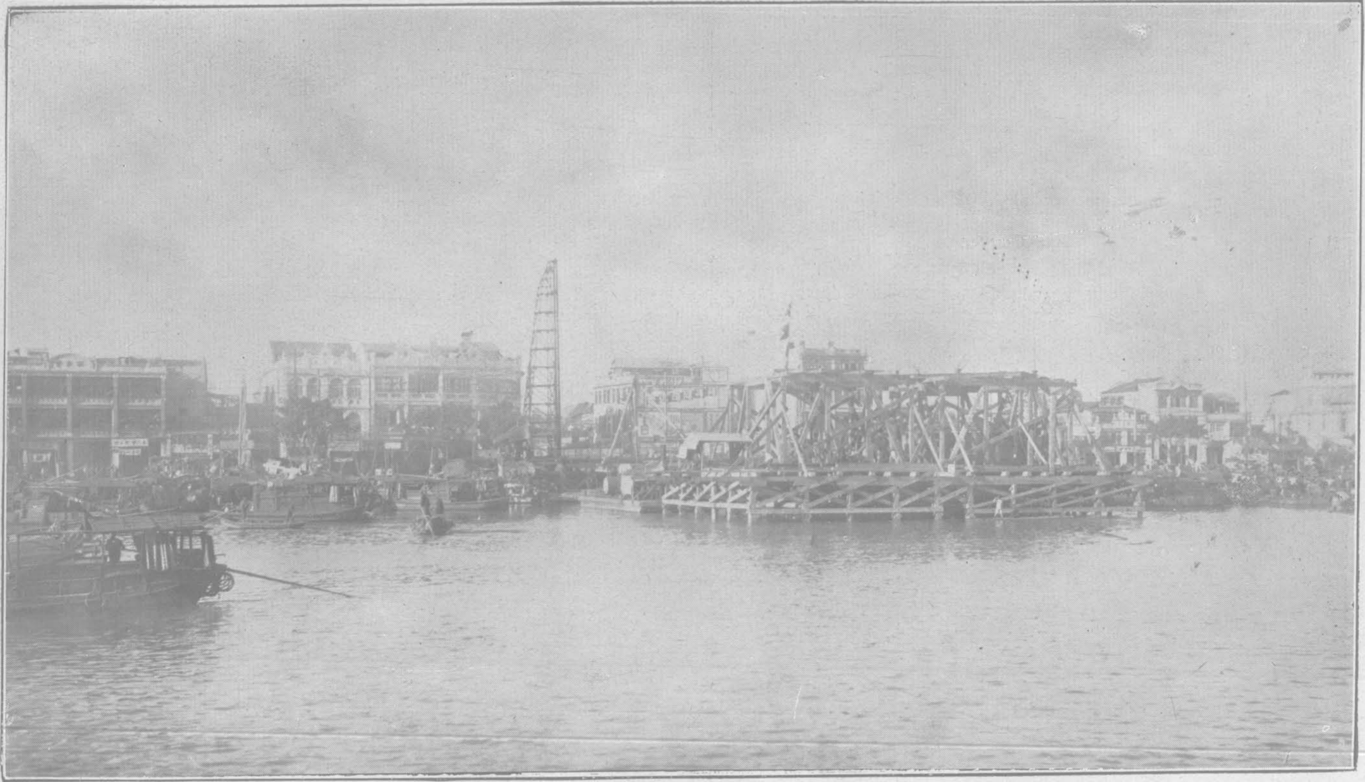
安 裝 河 中 橋 臺 鋼 板 圍 擋 時 之 情 形
