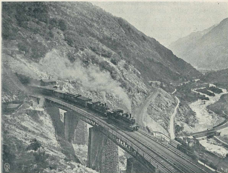
La ligne du Saint-Gothard près de Giornico.
