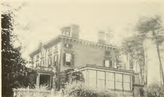
FIG. 61.—Canfield house at Dover, N. J.
