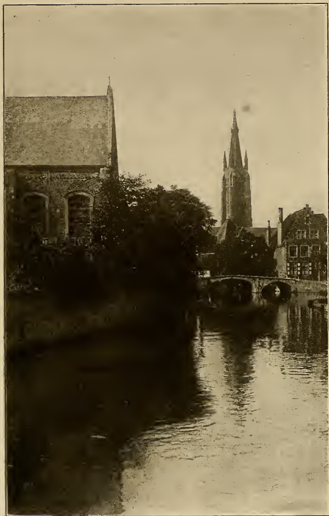
· BÉGUINAGE BRIDGE, BRUGES.
