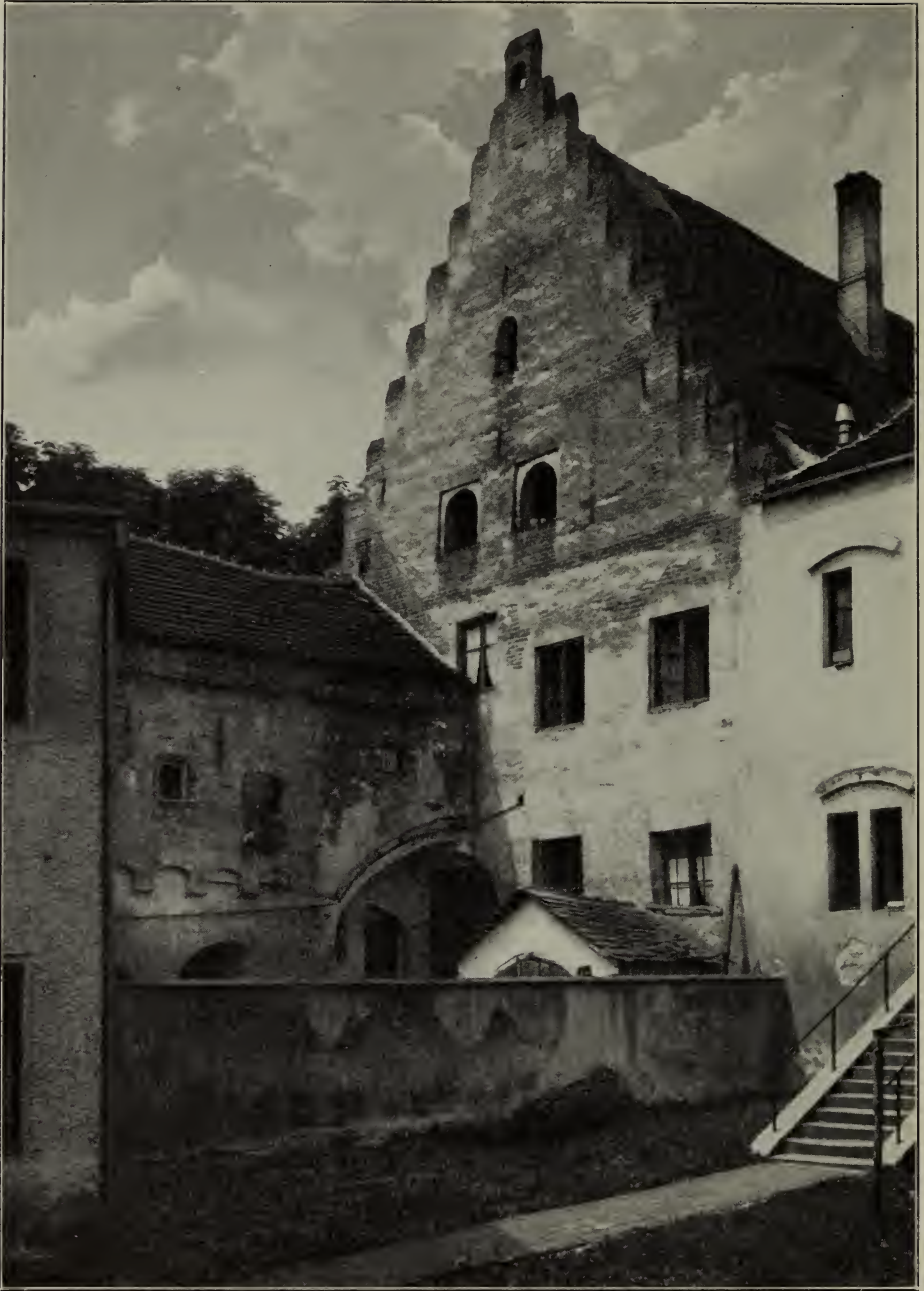
Fig. 22. Dingolfing. Ansicht des »Schlosses« von Nordosten.
