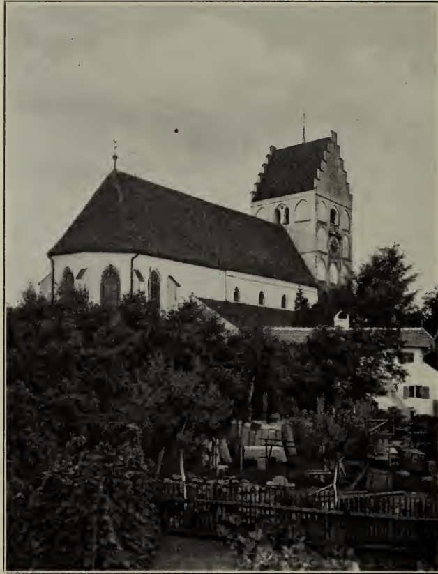
Fig. 88. Reisbach. Ansicht der Pfarrkirche von Nordosten.
