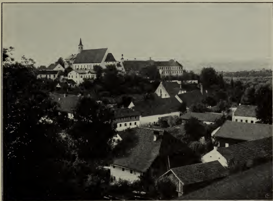
Fig. 64. Niederviehbach. Ansicht des Klosters von Südosten.
