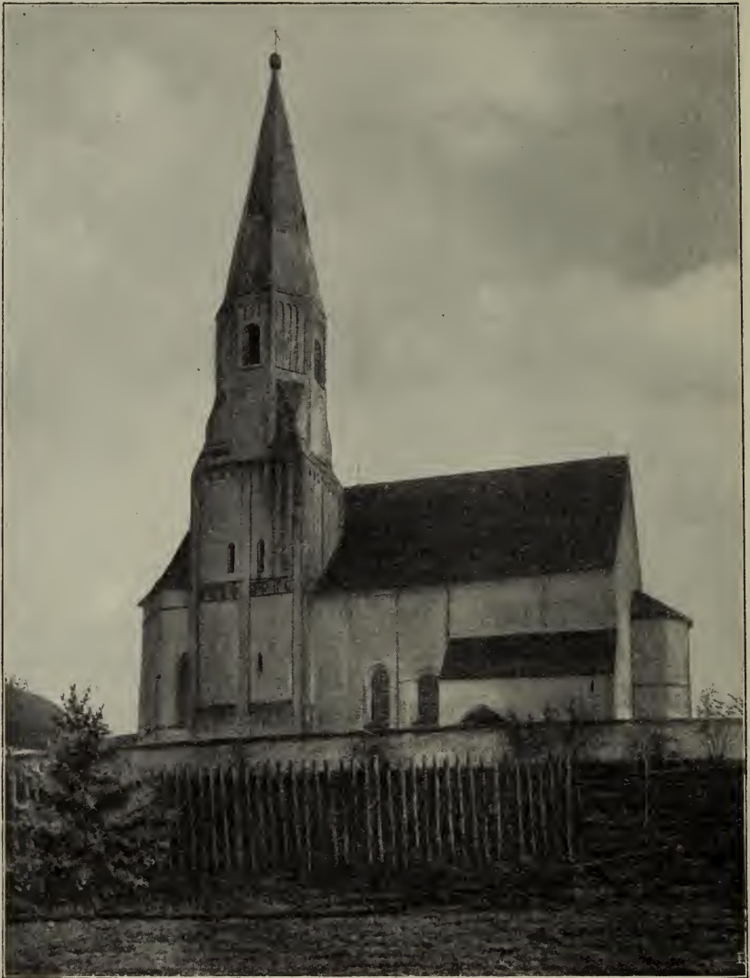
Fig. 77. Oberdingolfing. Ansicht der Kirche von Norden.
