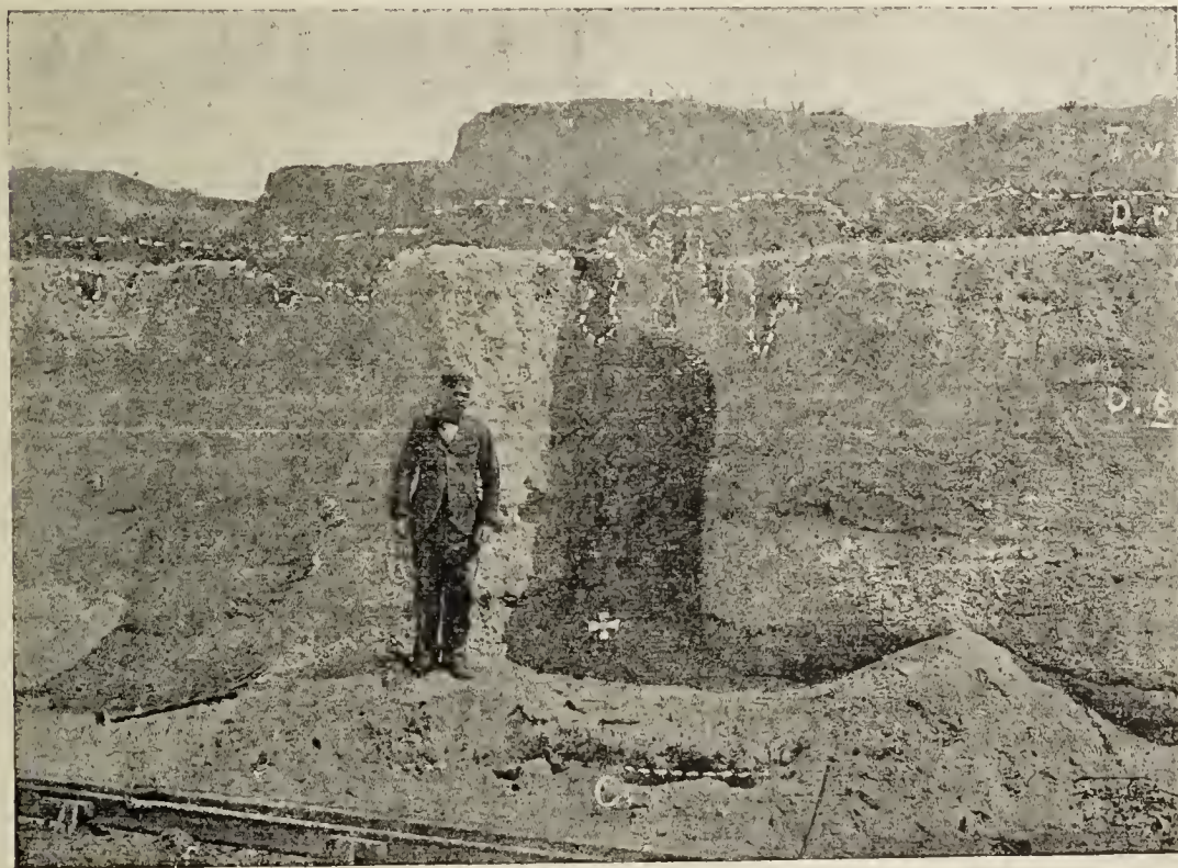
FIG. 3. — Photographie du front d'attaque de la ballastière de Tilloux. T. v. , terre végétale. D. r. , diluvium rouge; D. g. , diluvium gris; C. , craie; X, point où gisait la défense d'Éléphant.
