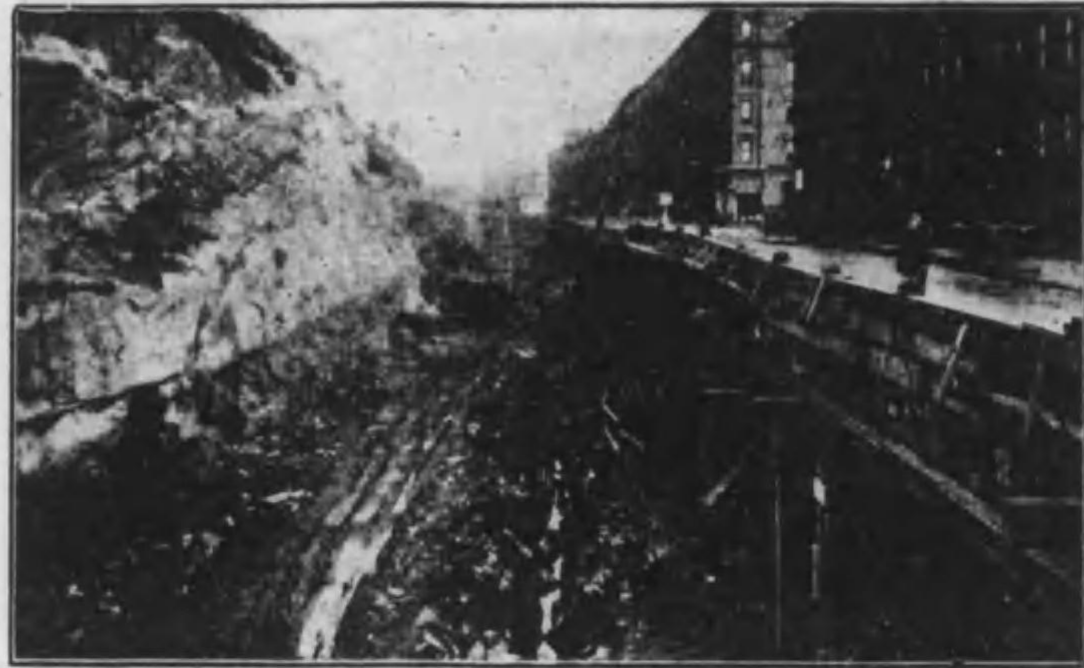
第十四圖 セント・ニコラス公園附近に於ける開放掘鑿と屋甲
