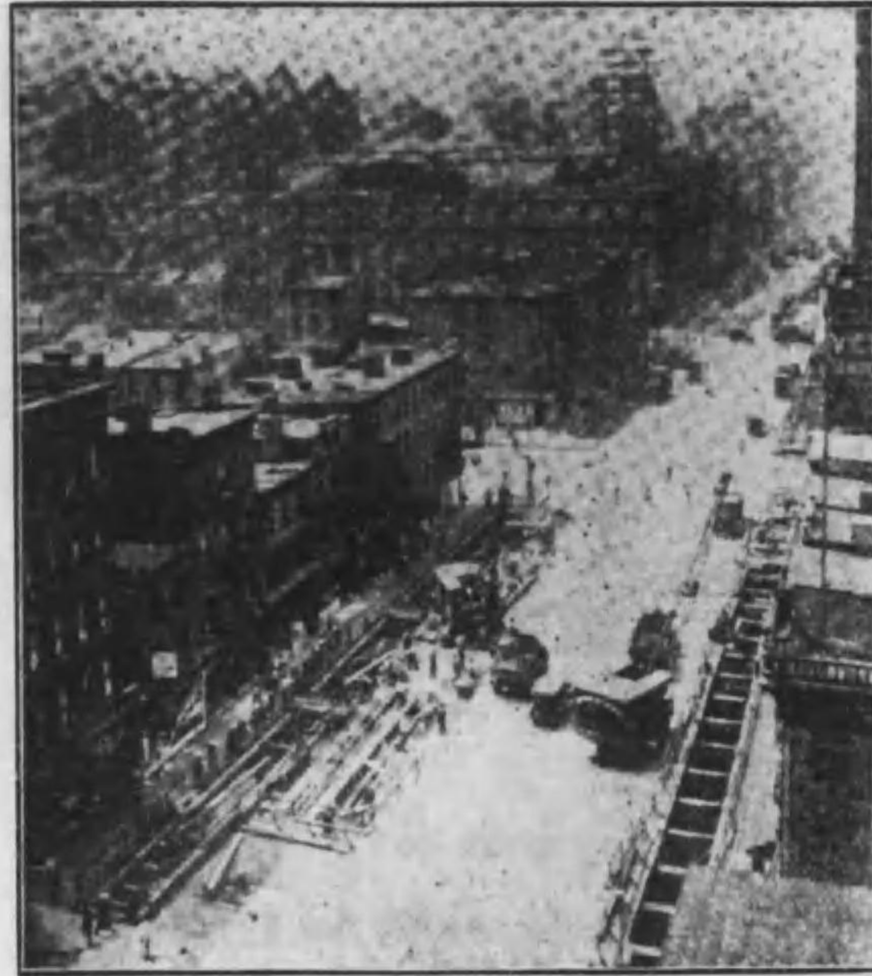
第四圖 第四十一街から見たる第八通南の工事状況
