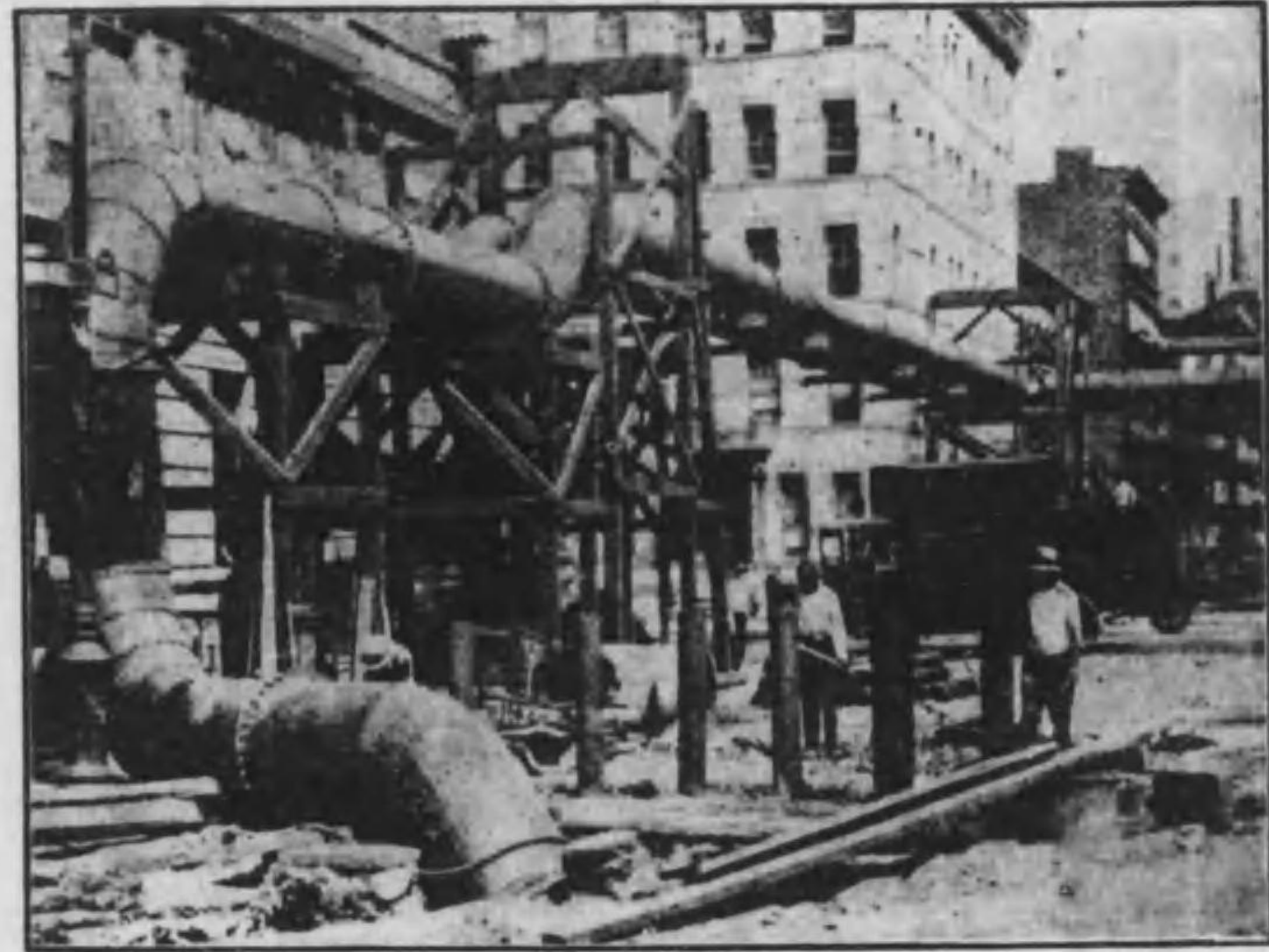
第十三圖 セント・ニコラス通に於ける瓦斯本管の側逸作業
