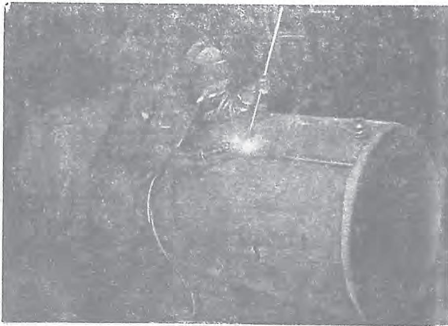
第 58 圖 用原子氫焊接鋼桶。
