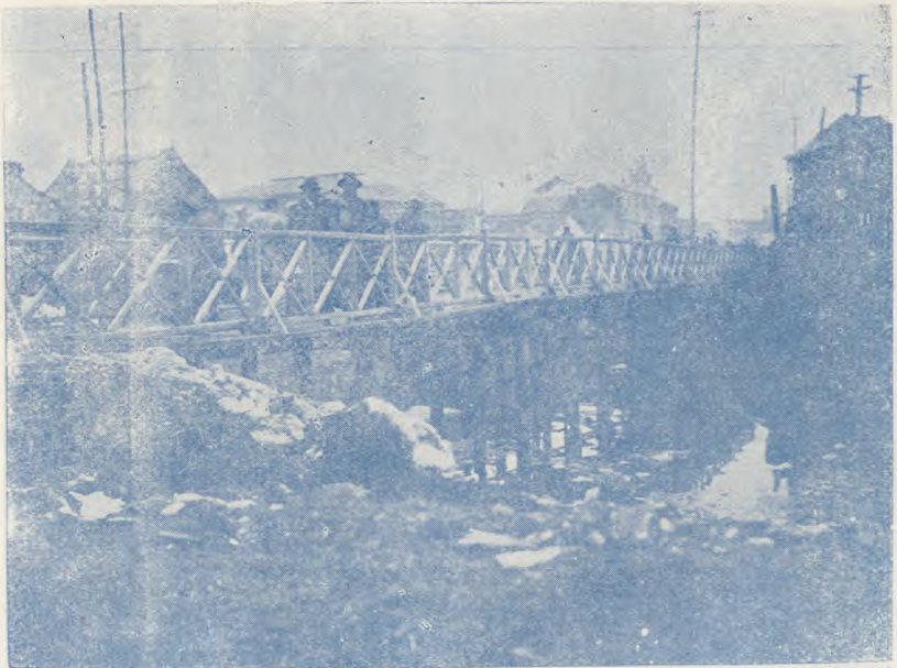
四 象 橋 旁 新 建 之 人 行 橋
