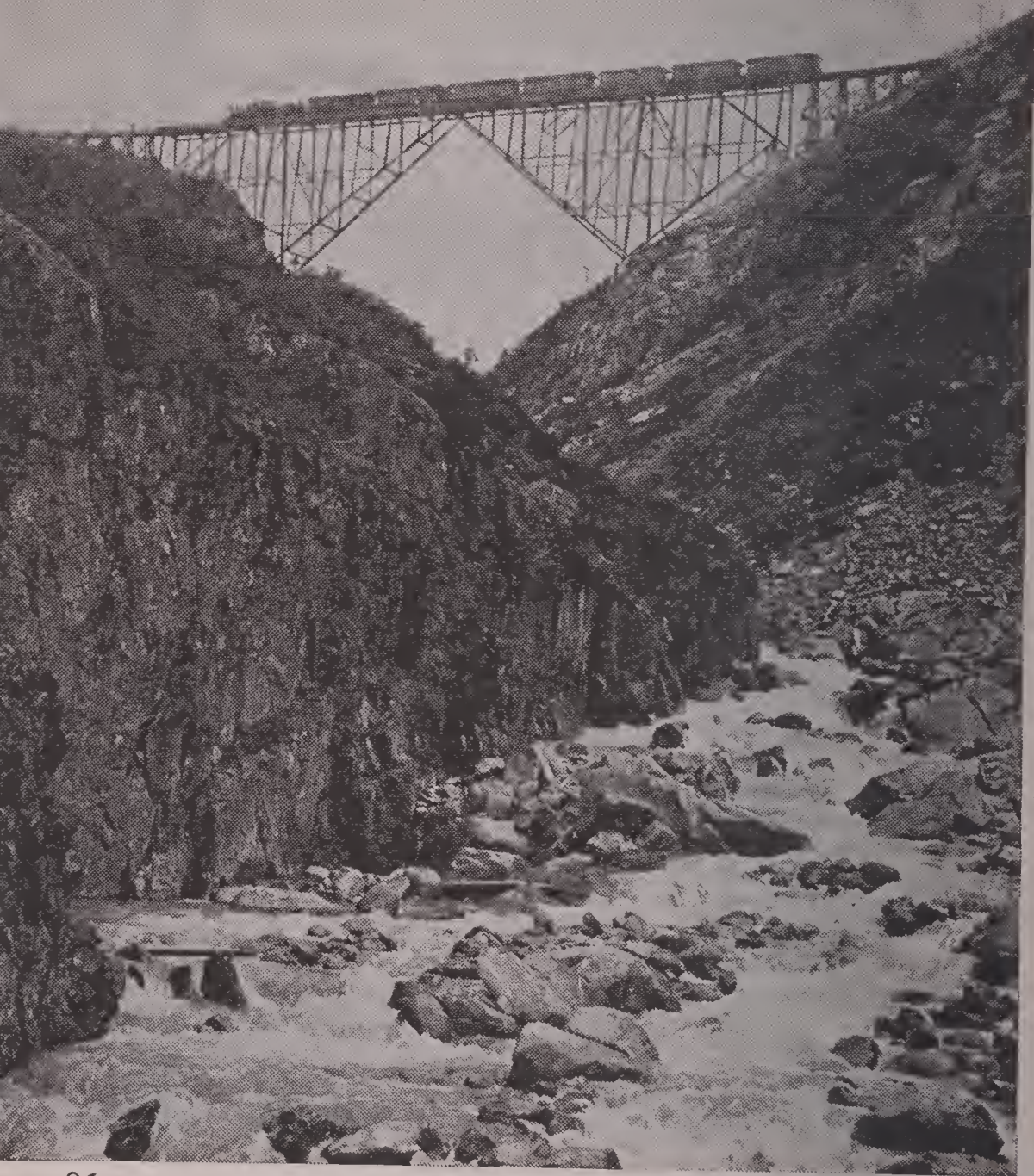
Образец инженерного искусства на Аляске. Железнодорожный путь Уайт Пас-Юкон пересекает ущелье по высокому консольному мосту.
