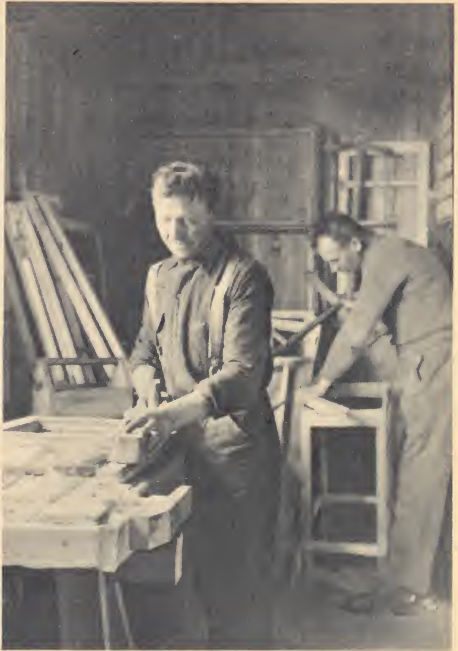
Patalpos remontuojamos savo jėgomis
