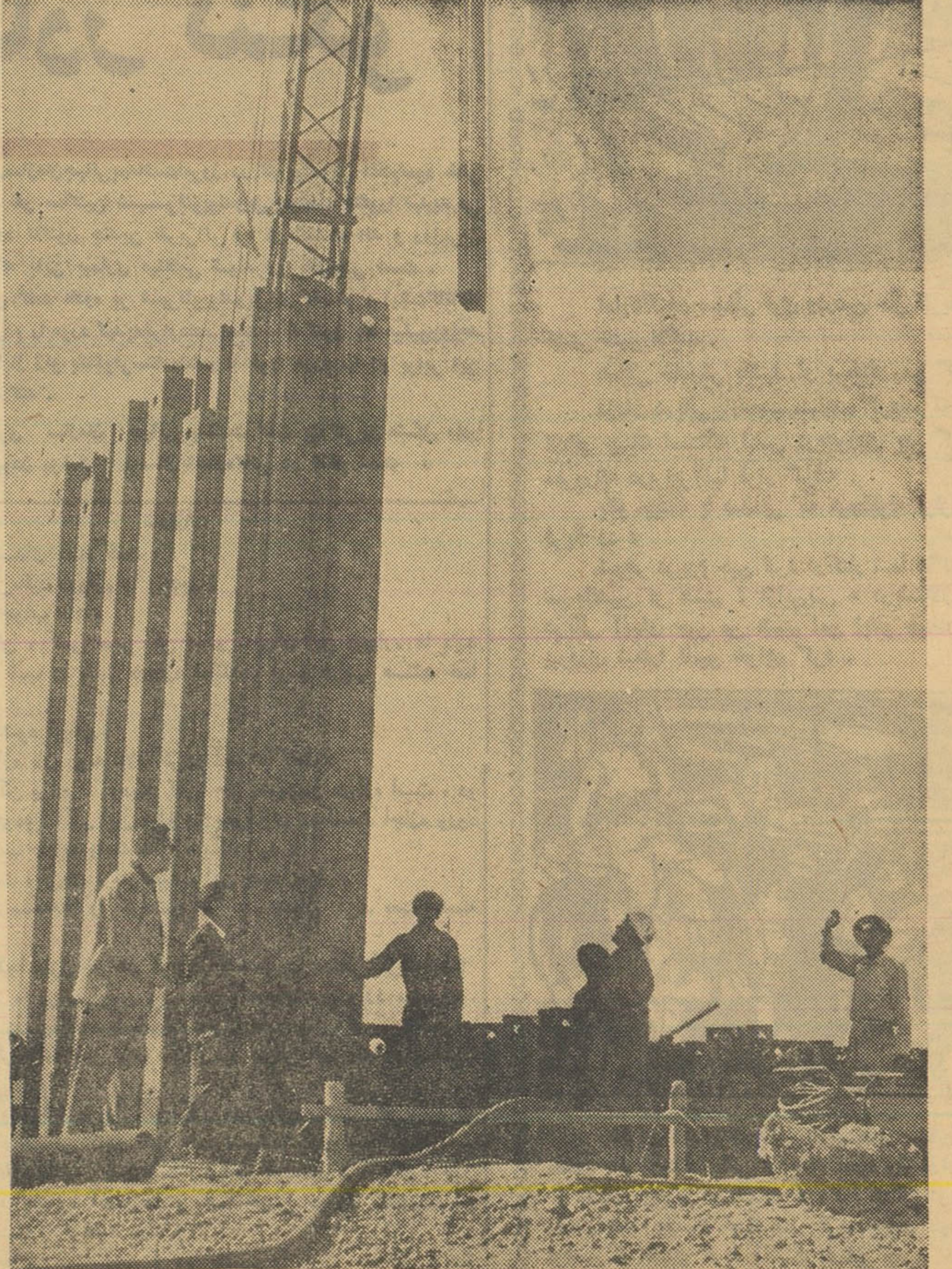
یک نمونه دیگر از پیل های ۱۷ متری که بعمق رودخانه فرو برده میشود
