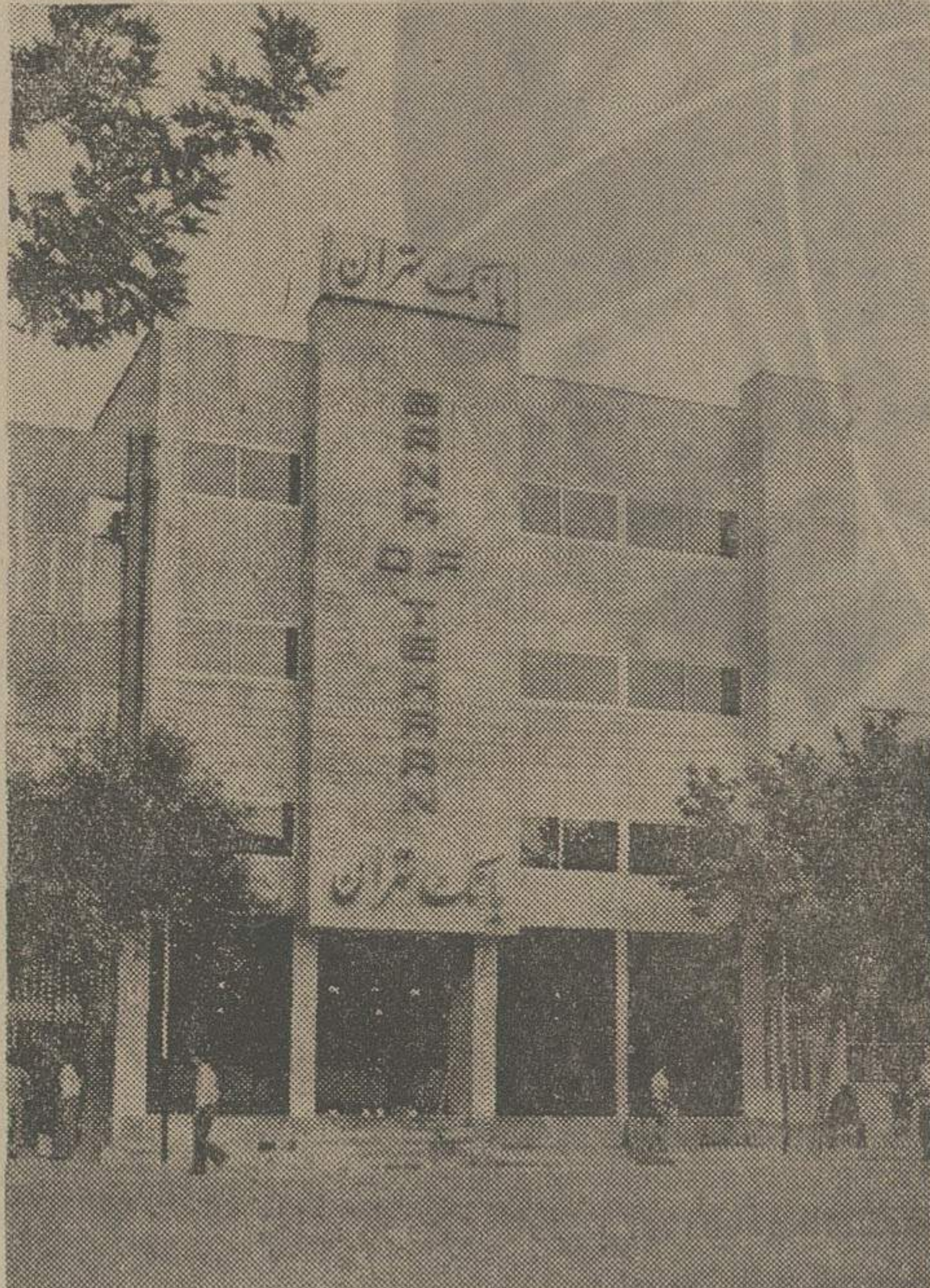
نمای خارجی ساختمان بانک تهران شعبه شاهی
