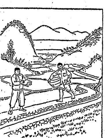
(15) 为了測量渠道的流速，蔡炳发就把谷糠撒在渠道的水里，跟着谷糠跑，一边跑一边計算时间，这样不知跑了多少谷糠，终于弄清了水流的流速。
