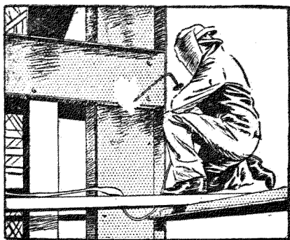
第3圖 鐵樑的電接焊。
