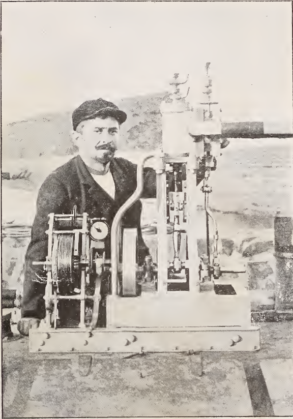
PETIT CHEVAL-VAPEUR FIXÉ SUR LE ROUFLE DU ROLAND ET CONSTRUIT AU LABORATOIRE PAR LE MÉCANICIEN DAVID.
