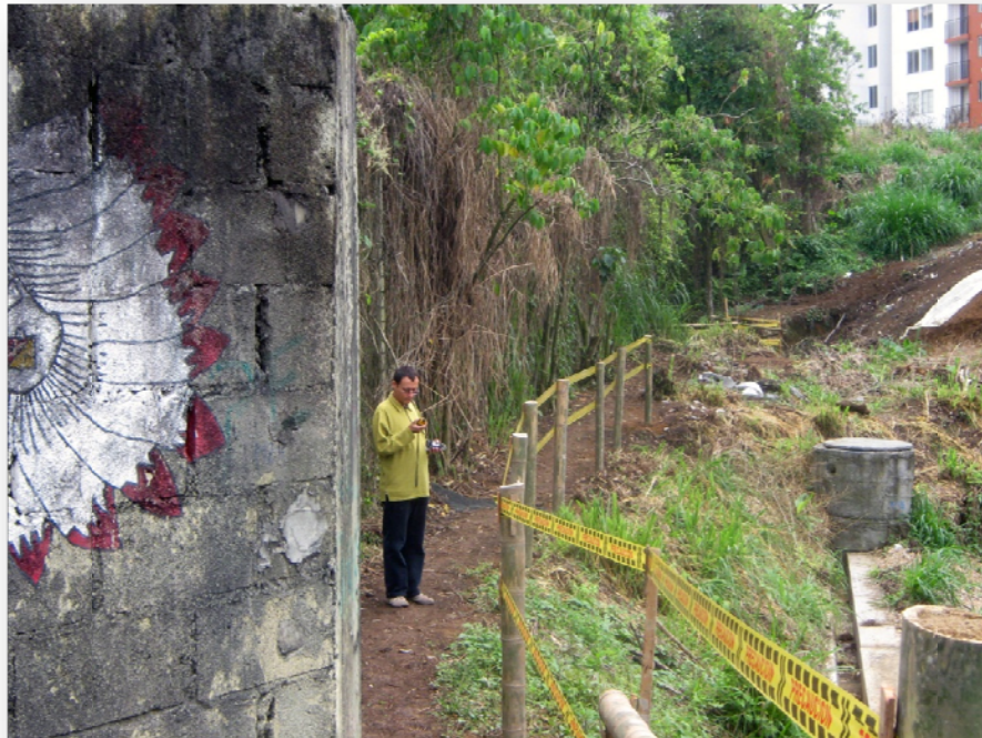
Foto 2. Georreferenciación alrededor de los caisson.
