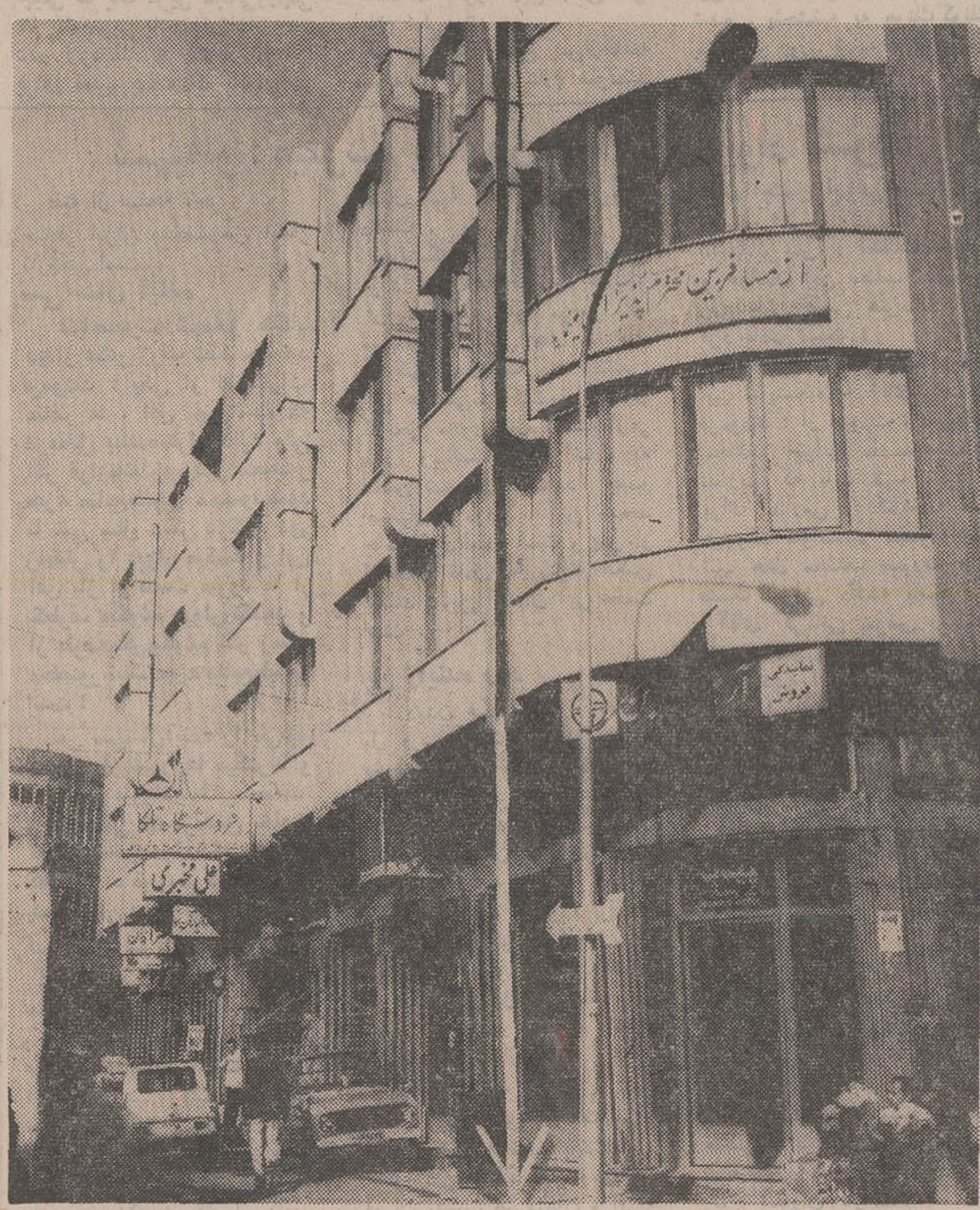
نمای ساختمان مسافر خانه اکباتان - ارتفاع سقوط حسین محسنیان با فلش مشخص شده است
