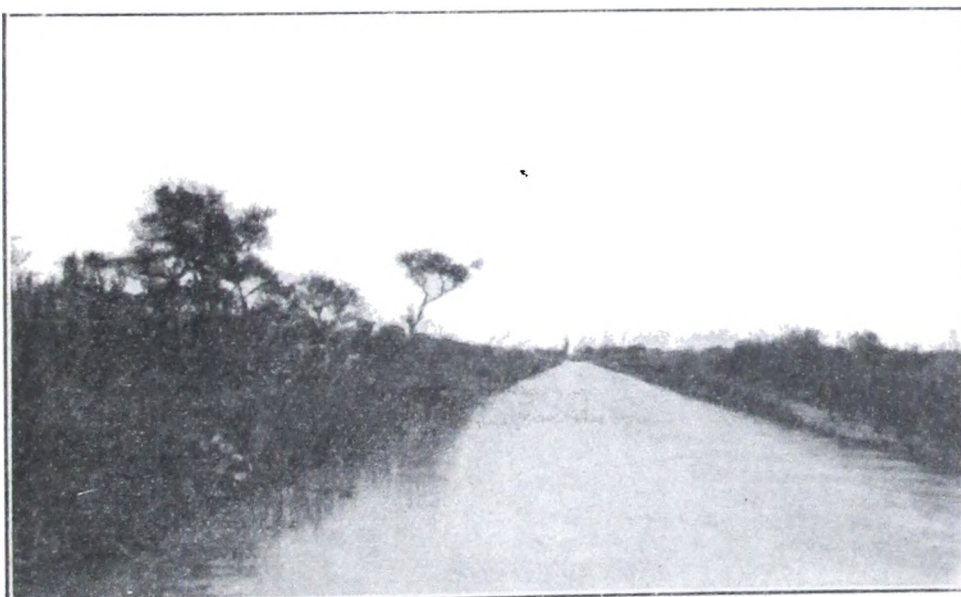
Zanja del Pay Garabí al canal de la Serna
