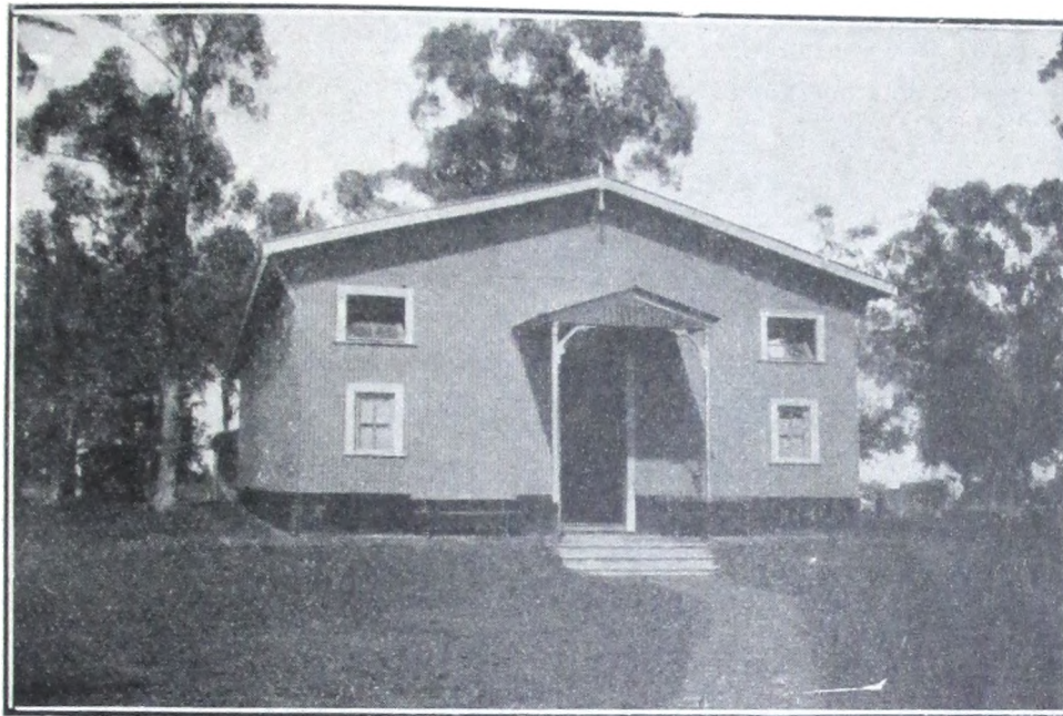
Construido por el aumento de la población hospitalaria
