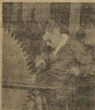
第 312 圖 用氧快炬於鋼銜 上銲接特種鋼合金
