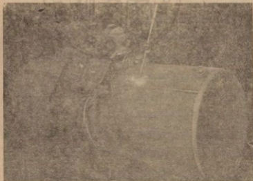
第 58 圖 用原子氫炬接鋼樑。
