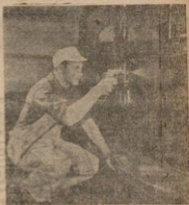
第 317 圖 噴射快乾漆於汽車上
