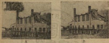
第 224 圖 同一工廠之兩照相：A，所用收集塵埃之料器理備沈澱器在未通電流時；B，通電流
