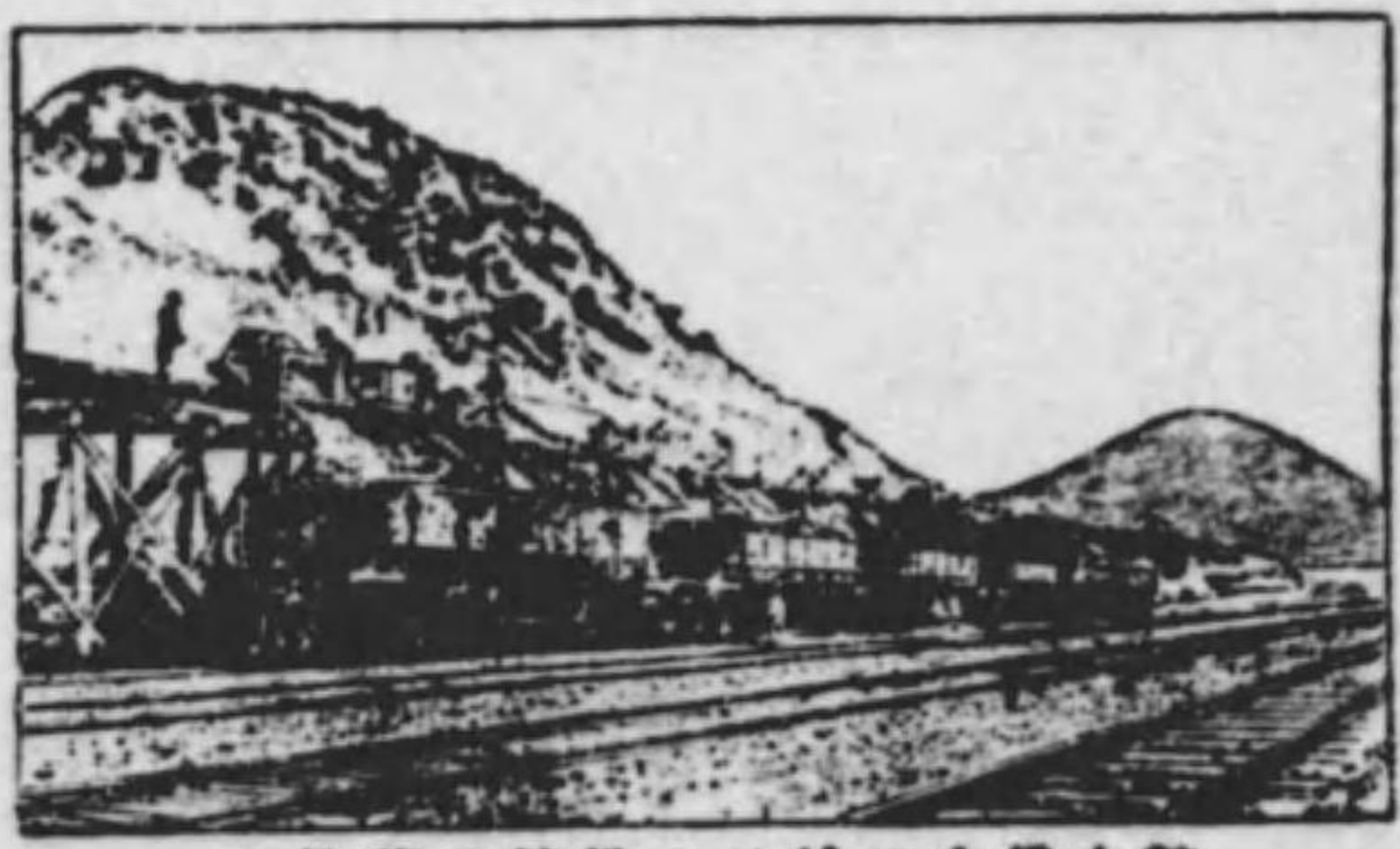
鞍山鐵山の鑛石を積込む様子
