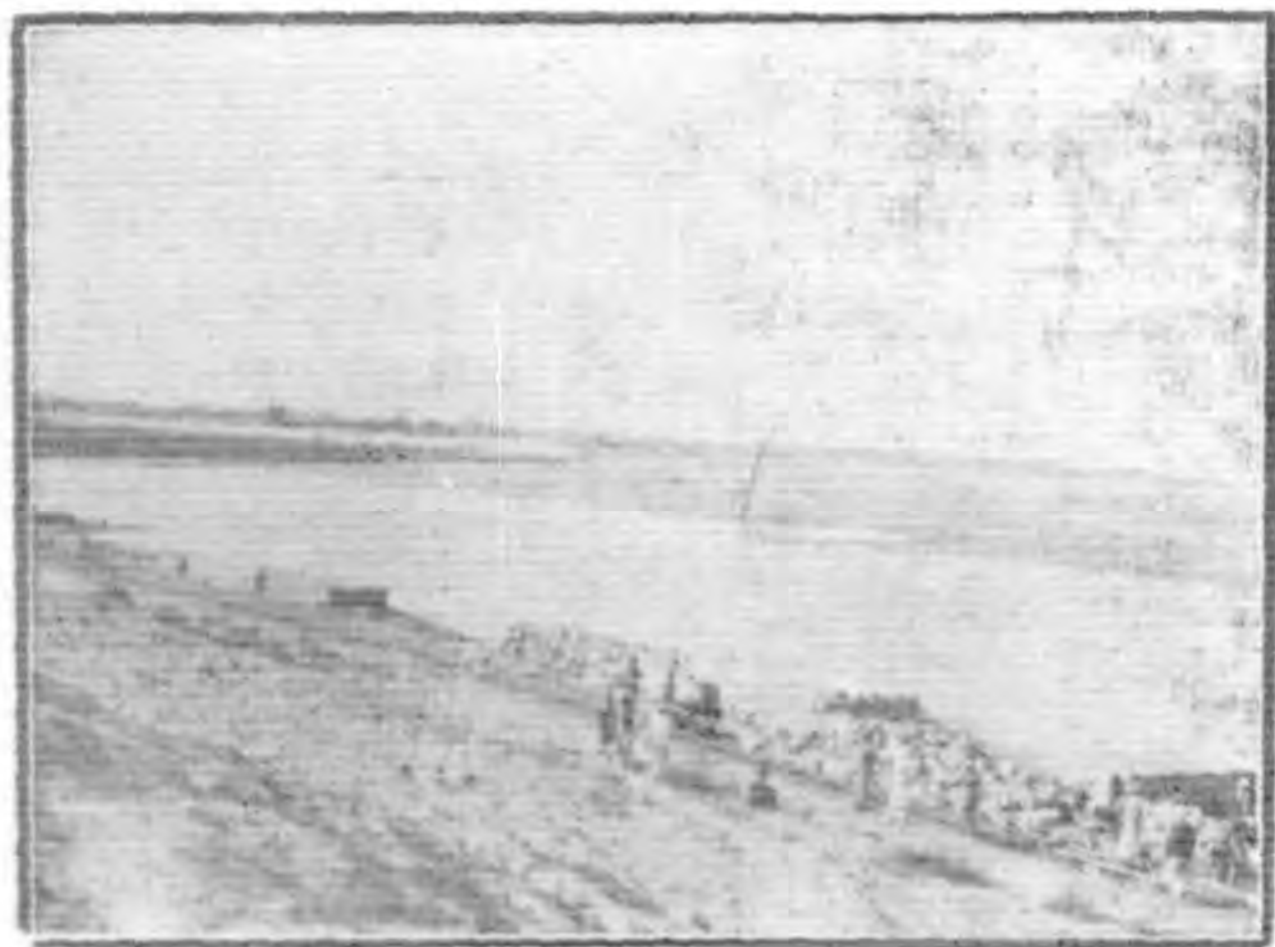
永定河堵口工程運輸石料情形
