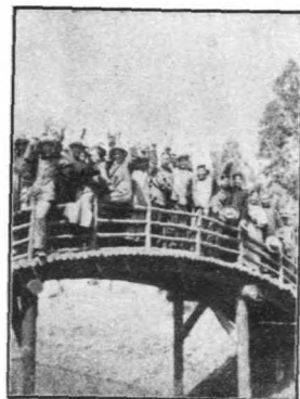
全體職工於寧園橋上
