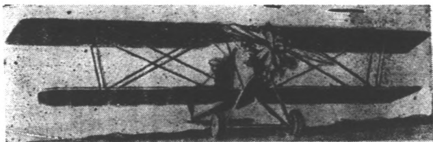
142. Aero A-32: 摩托——420 馬力○地面速度——226km/HR. 升至3km, 需時 10.2分○燃料儲藏, 足供四小時○機關槍四架, 可載炸彈105KG.
