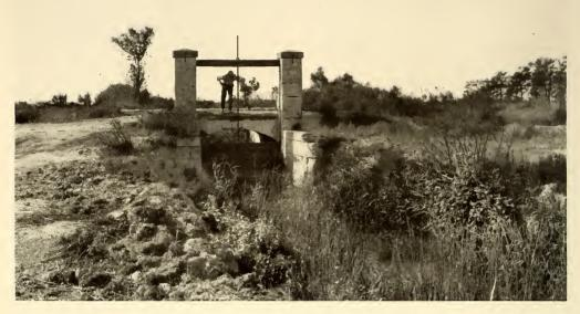
A SLUICE-GATE IN THE CAMARGUE DRAINAGE SYSTEM
