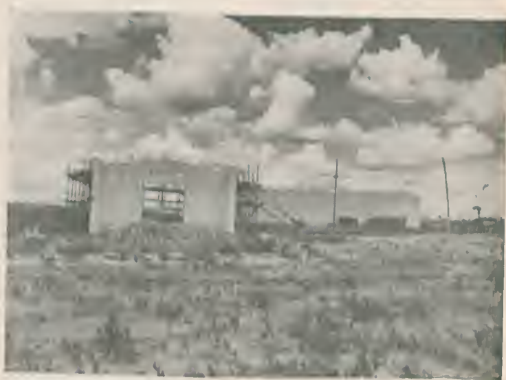
Igreja Ecumênica (já em fase de conclusão). Núcleo 8
