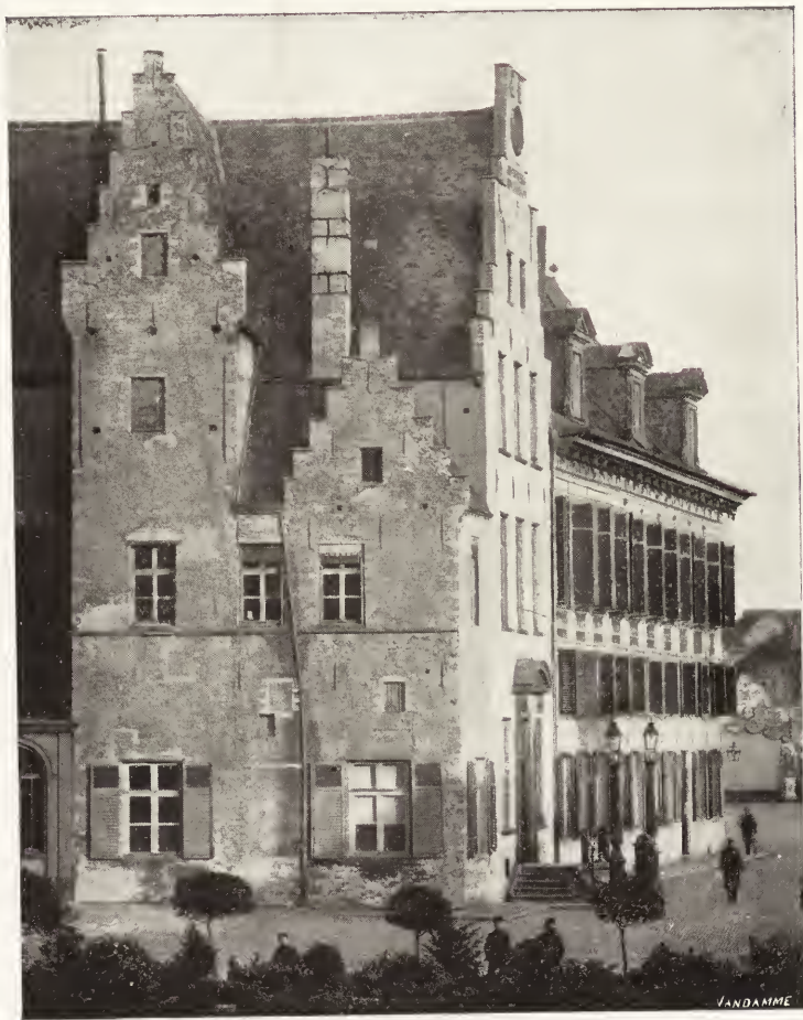
Façade principale du cinquième bâtiment
