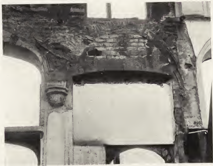
B. INTÉRIEUR DU PIGNON VERS LA GRAND'PLACE.
