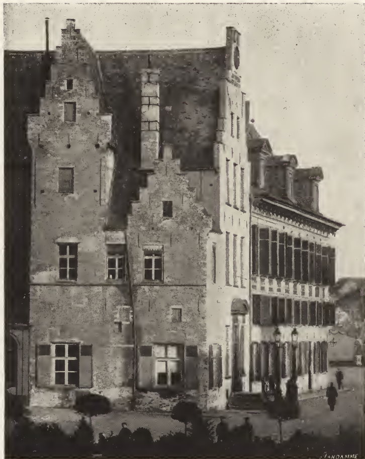
Façade vers la Métropole
