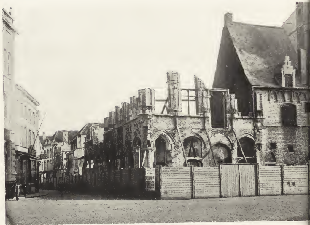
A. VUE DANS LA RUE DE BEFFER, APRÈS LE DÉGAGEMENT.
