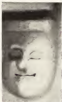
Corbeau supportant le degré inférieur du pignon principal (Planche I, 1)
