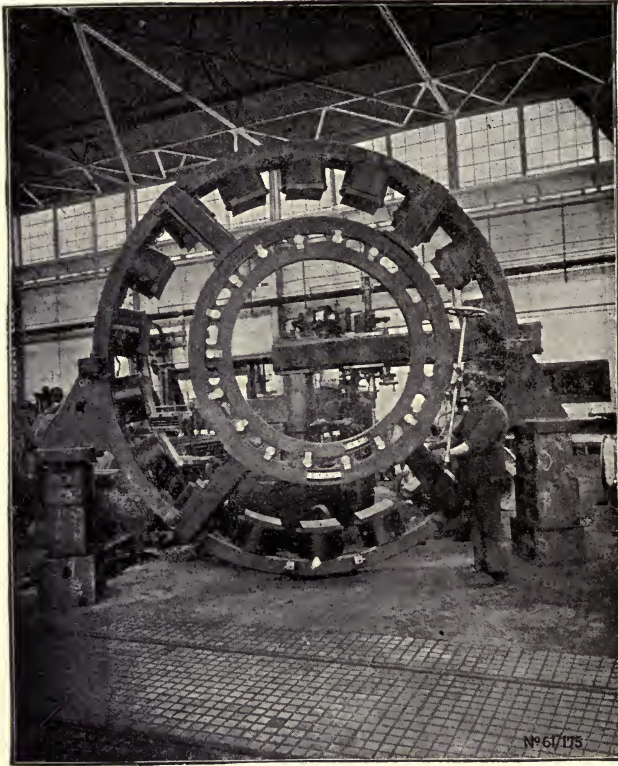
FIG. 115.—Eighteen-Pole Magnet Frame ( Körting Bros. ).
