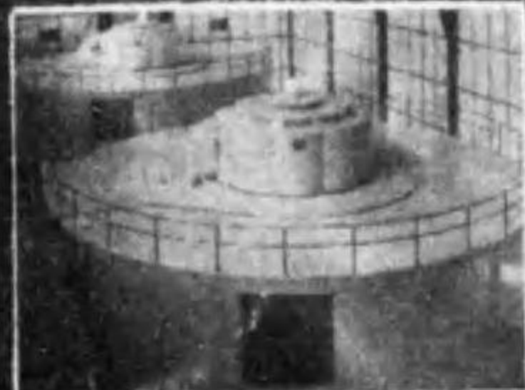
東芝製93.000KVA 傘型水車発電機
