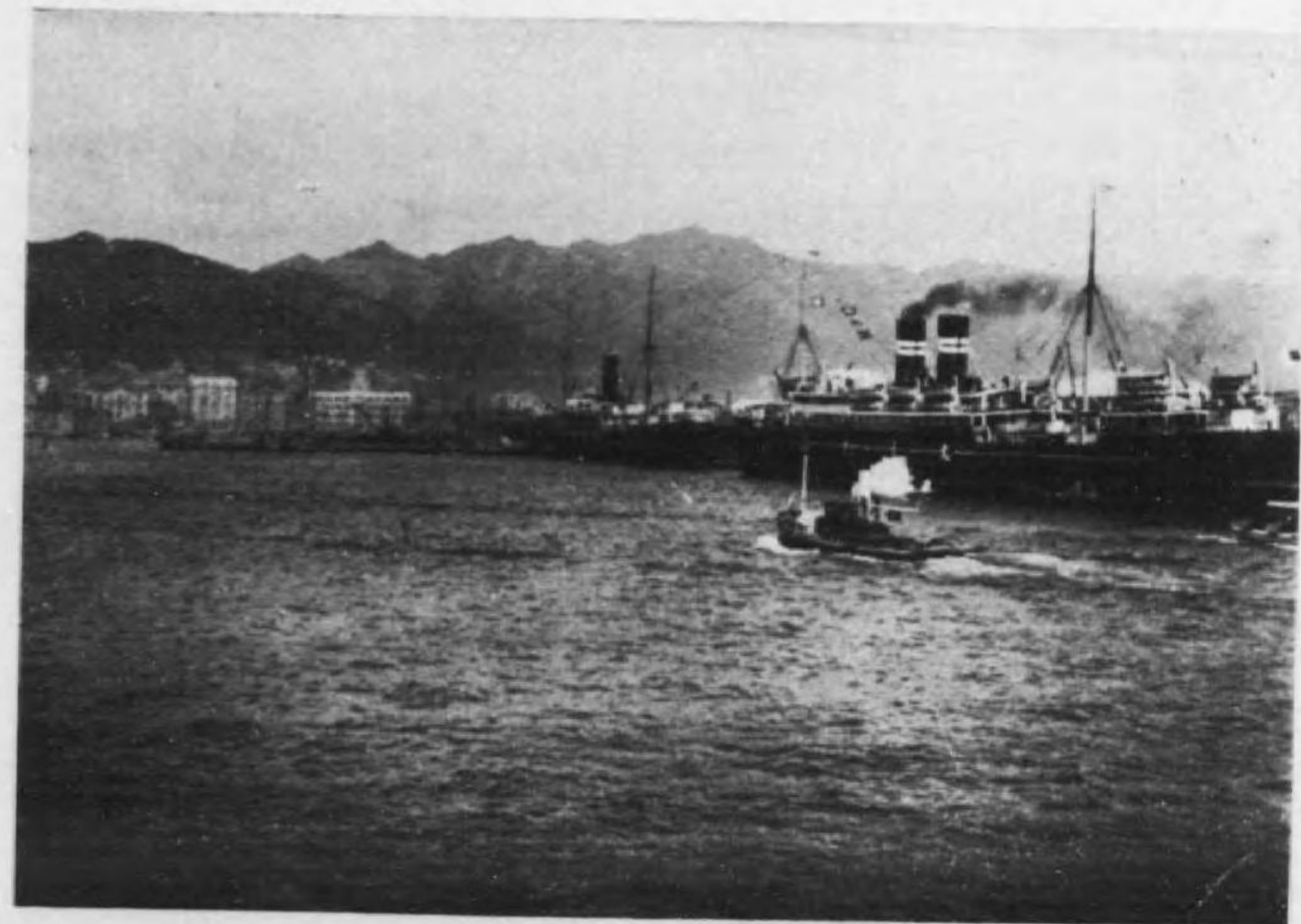
船 舶 給 水 状 況
