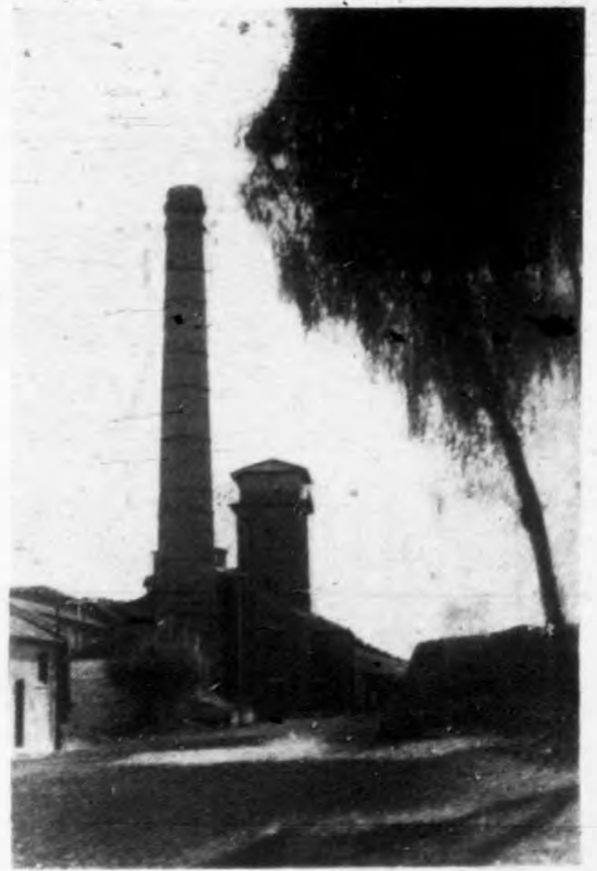
本廠之煙囪與水塔
