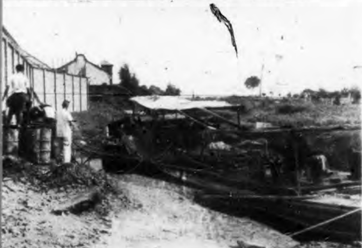
燃料起卸時及灌入油池中情形
