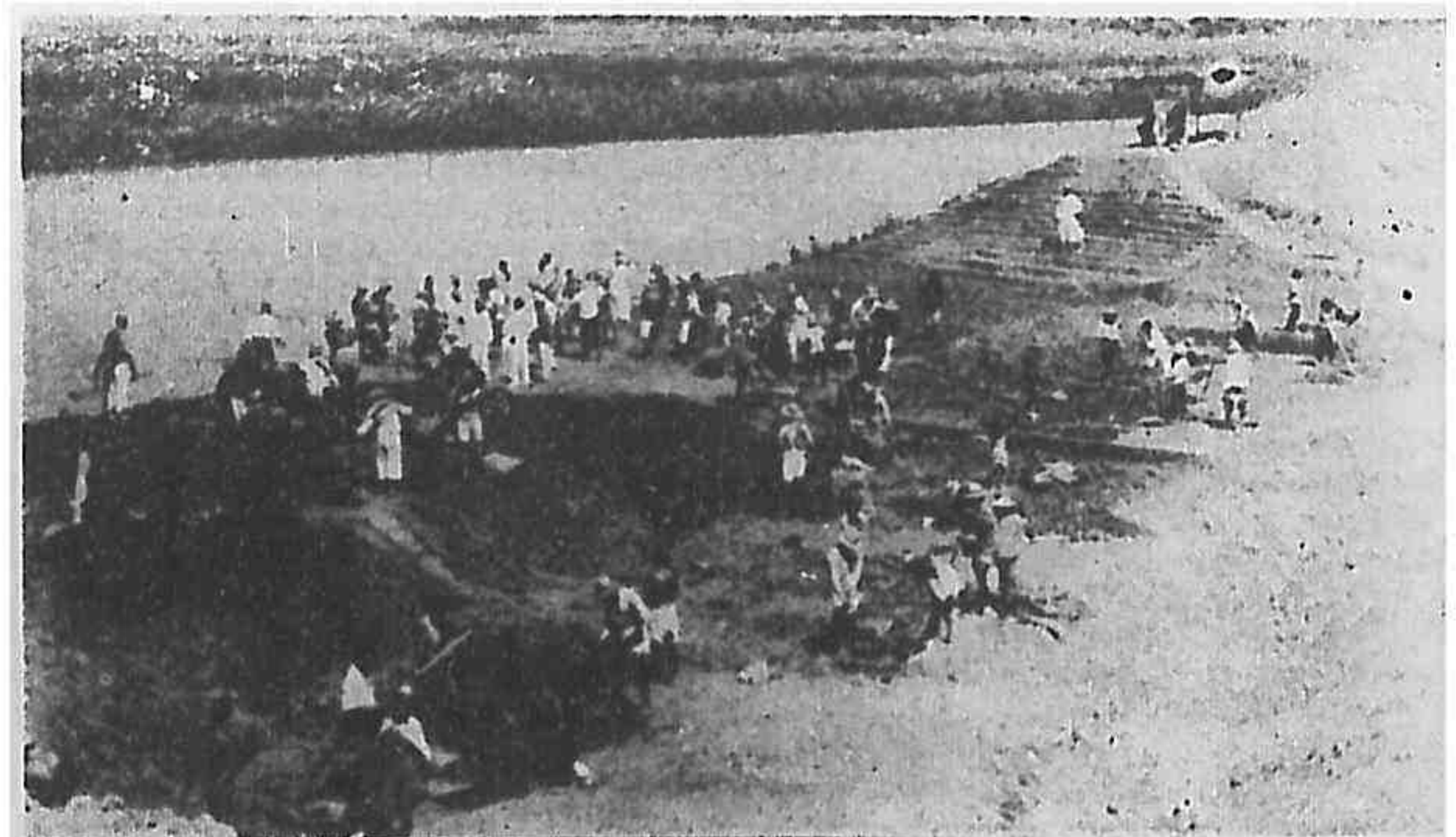
運河復隄工程高郵汛八里松翻築工程情形
