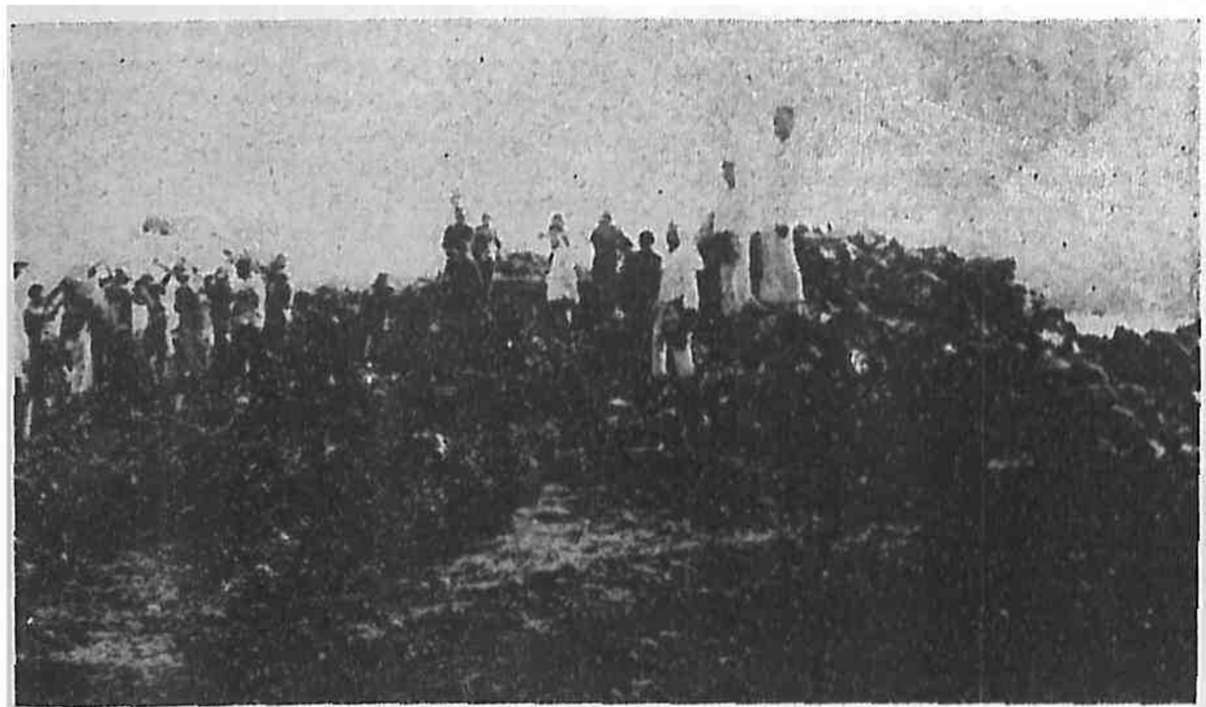
運河復隄工程高郵汛仁昌對岸缺口工程情形
