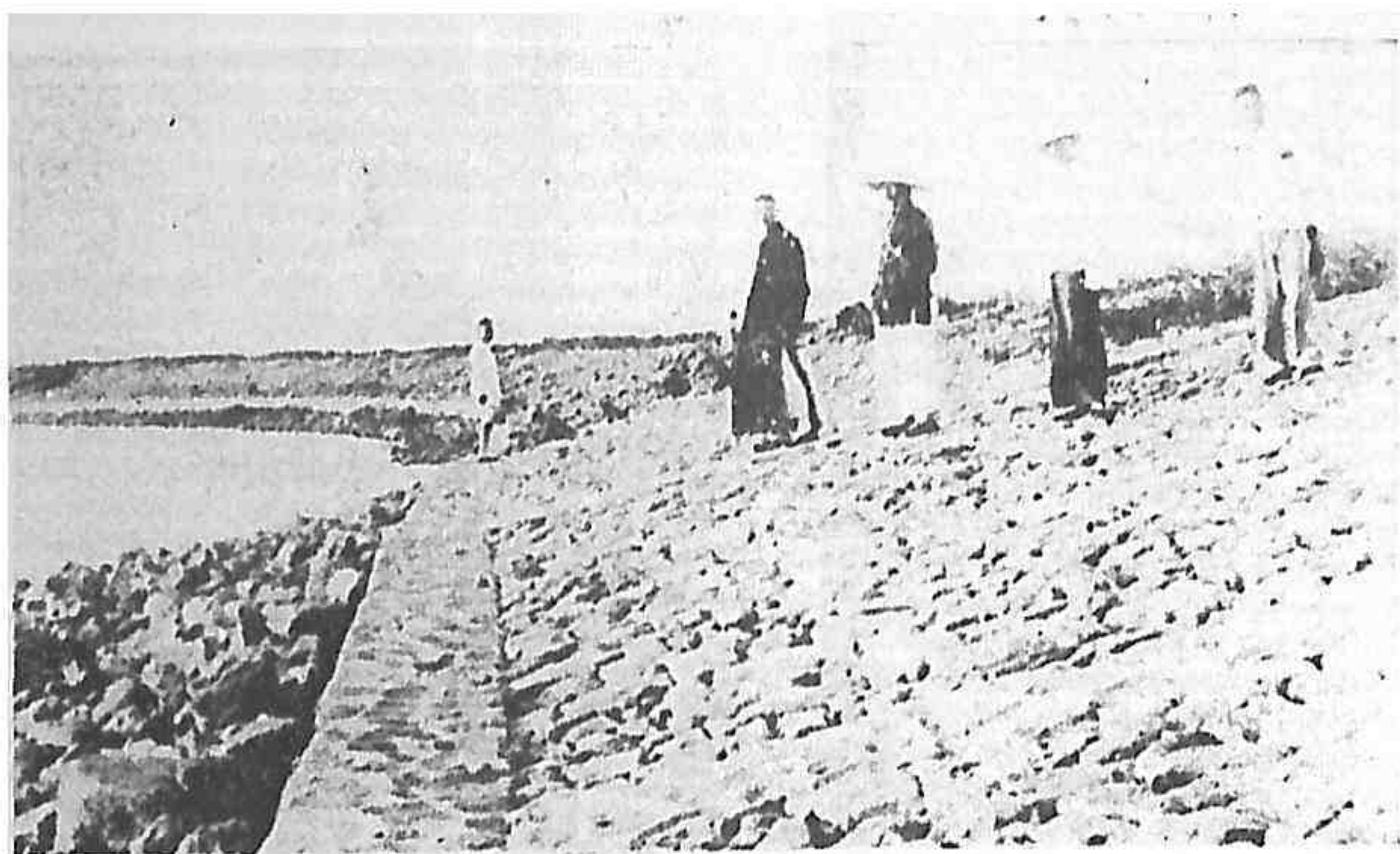
運河復隄工程高郵汛攔軍樓對岸碎石工程情形
