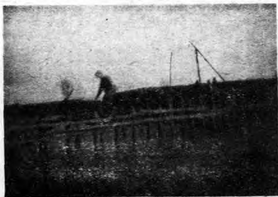
圖 89 建築樁壩之打樁工程
