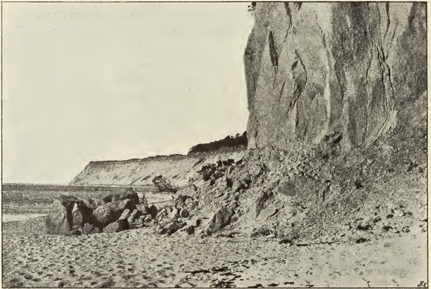
Abb. 34. Dieselbe Stelle wie Abb. 33, mehr aus der Nähe gesehen. An der Wand deutliche senkrechte Klüfte, an welchen sich zum Teil der Schollenabbruch vorbereitet.
