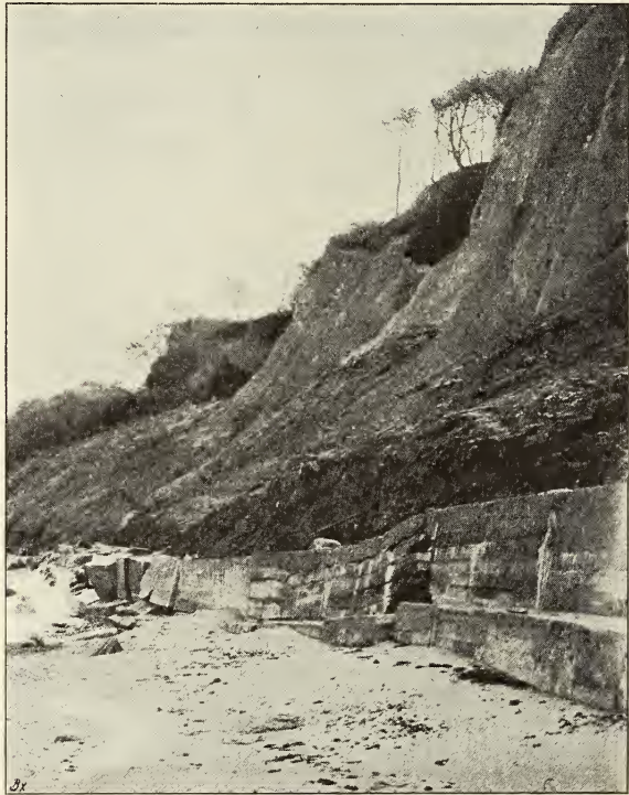
Abb. 43. Dieselbe Schutzmauer wie in Abb. 42, durch die Brandung und den Druck der am Gehänge abgleitenden Schuttmassen gelockert. Aufgenommen im September 1904.
