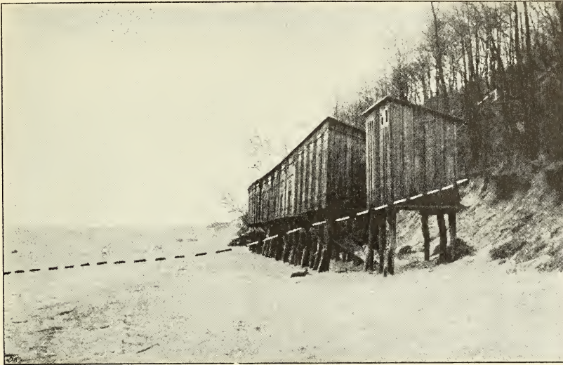
Abb. 48. Wirkung der Stürme im Januar 1905 am Damenbade bei Neukuhren. Die vordere Reihe der Badebuden ist fortgerissen, der Strand erheblich erniedrigt und verschmälert. Die punktierte Linie giebt den Verlauf des Strandes vor der Zerstörung ungefähr wieder. Aufgenommen im März 1905.
