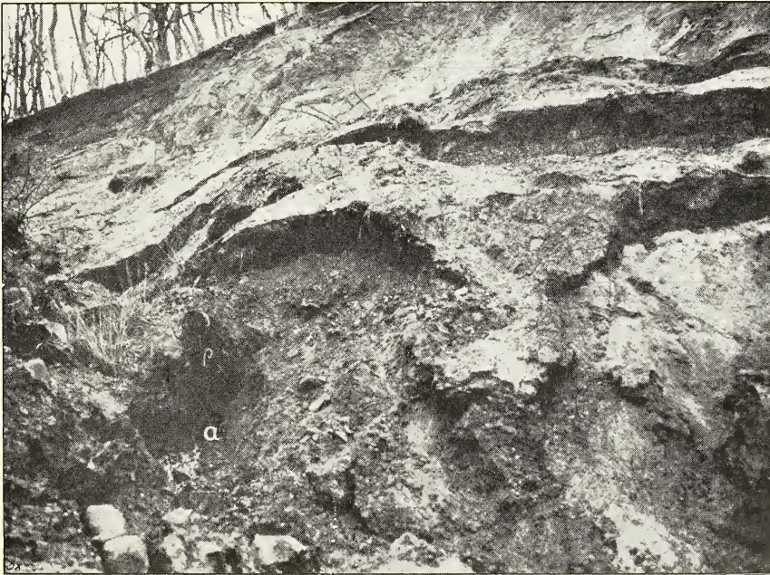
Abb. 29. Die bei a heraustretende Quelle hat den Hang unterminiert, die oberen Partien des Geschiebemergels sind stufenartig abgerutscht. Zwischen Warnicken und Georgenswalde. Aufgen. im Januar 1905.
