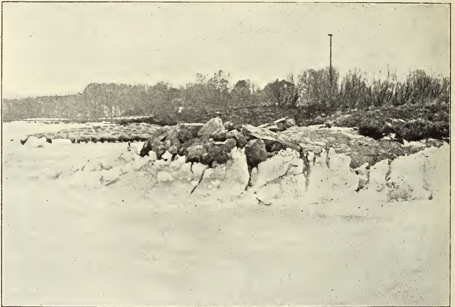
Abb. 4. Durch Eisdruck zerstörter Molenkopf am Löwentin-See.
